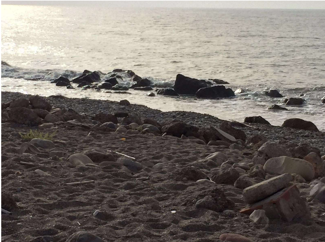
Figura 4. Estado actual de la escollera
