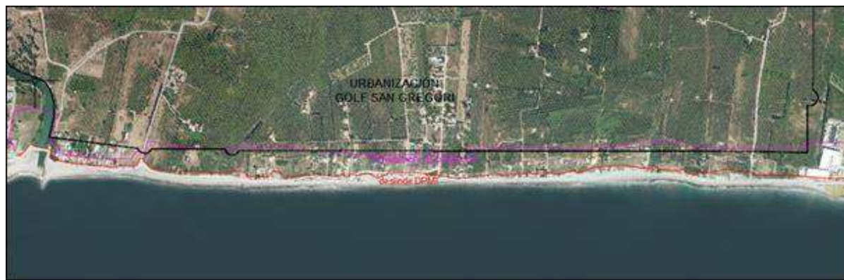
Figura 2. Fotografía ortogonal de la zona de actuación
