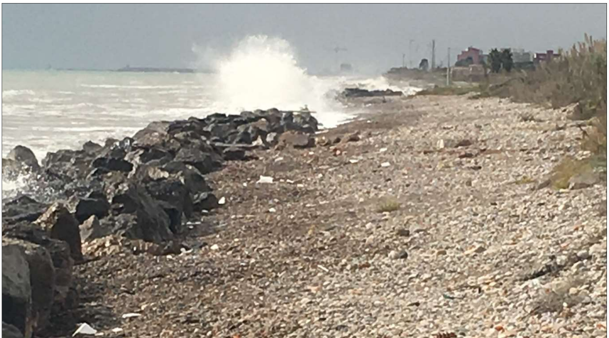
Figura 4. Estado actual de la escollera de protección (Fuente: HIDTMA)
