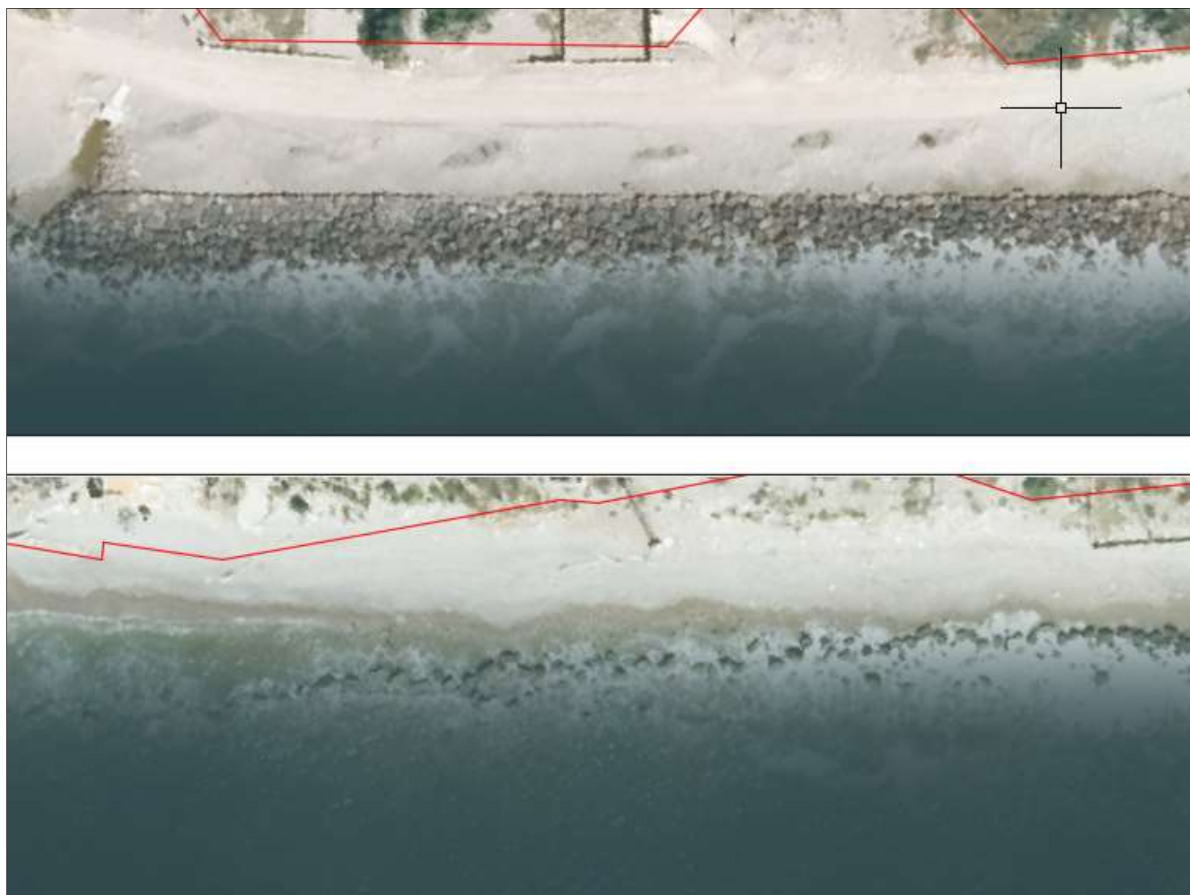
Figura 3. Ejemplo del estado actual de la escollera en diversos tramos del frente litoral de la urbanización.
