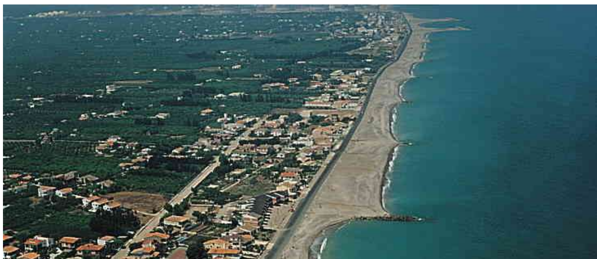
Figura 6 – Ejemplo de espigones de contención para la estabilización de la playa de La Torre en Almazora
