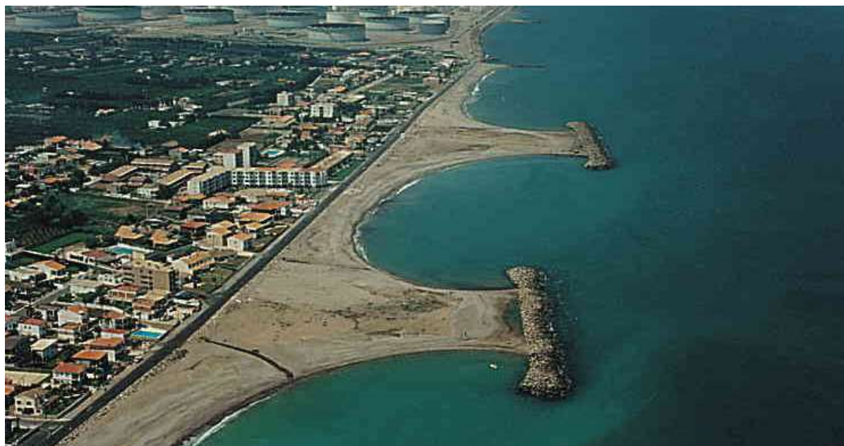
Figura 5 – Ejemplo de diques exentos para la defensa de playas en Almazora (playa de Benafeli)
