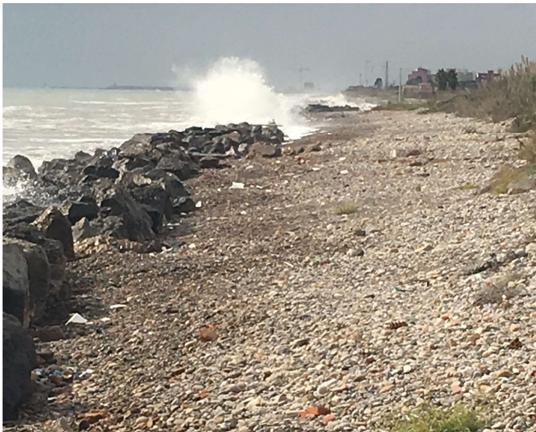
Figura 7. Estado de la escollera
