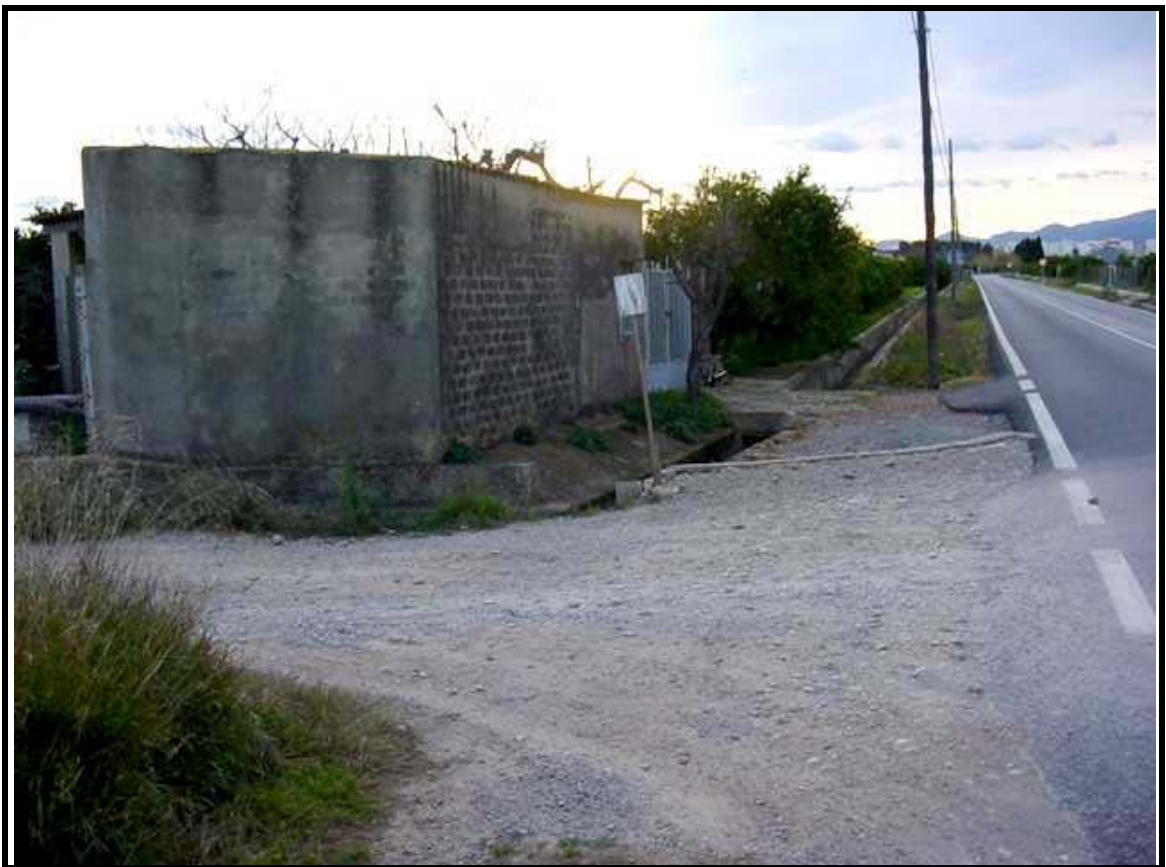
Edificación perteneciente a la parcela n° 125 del polígono 13.
