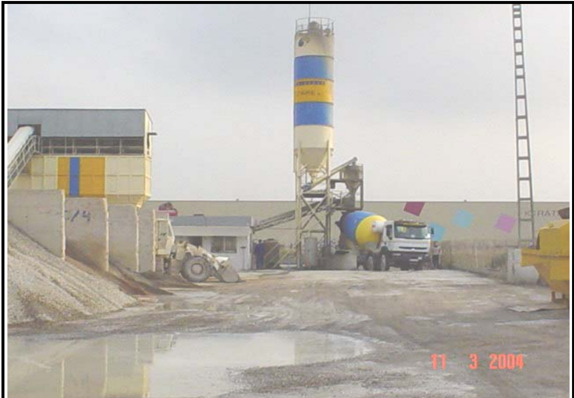
INSTALACIONES Y ACOPIOS.
