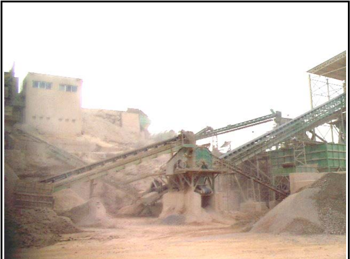
INSTALACIONES DE TRATAMIENTO.
