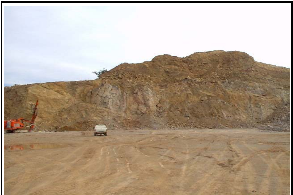
FRENTE DE EXCAVACIÓN.
