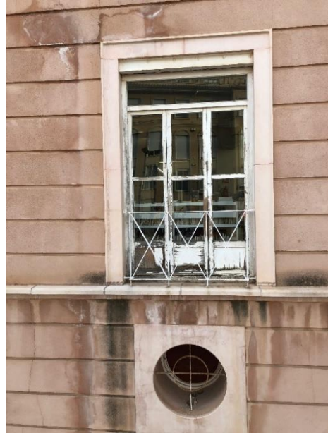
Estado actual de las humedades en las diferentes fachadas Fuente: El fabricante de esferas. 2021
