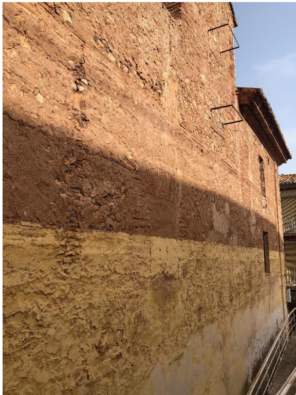
Detalle del estado de conservación de la fachada de la iglesia Fuente: El fabricante de esferas. 2021
