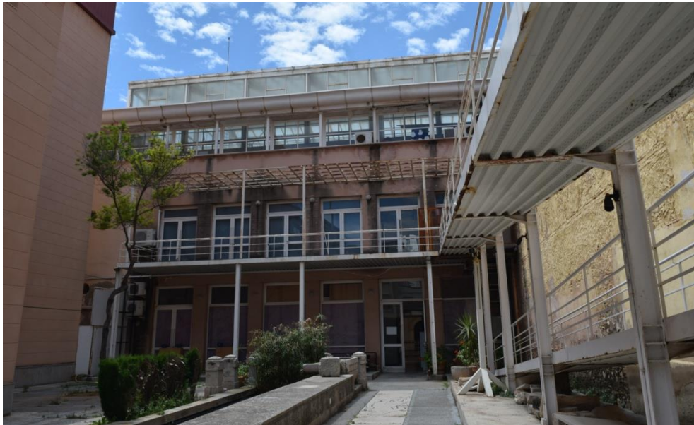
Fotografías del patio de la Casa de la Cultura La Mercé Fuente: El fabricante de esferas. 2021
