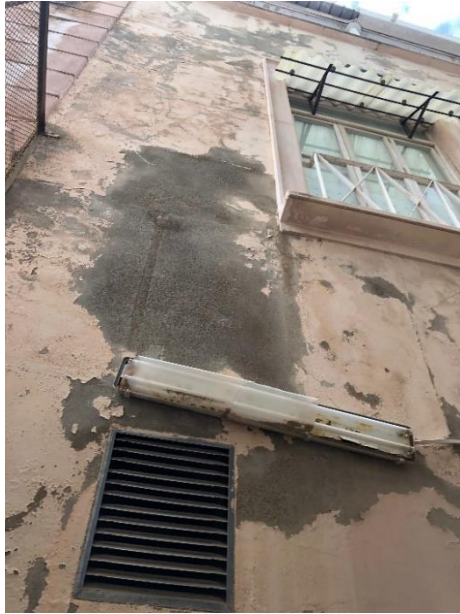
Estado actual de las humedades en las diferentes fachadas Fuente: El fabricante de esferas. 2021
