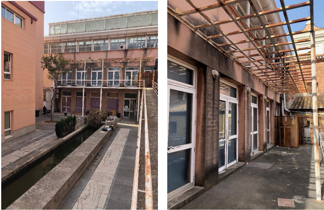
Elementos añadidos a la fachada del Corralot Fuente: El fabricante de esferas. 2021
