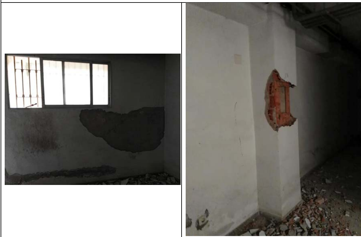
Vistas de distintos elementos resistentes ubicados en planta sótano (muro de hormigón perimetral y pilar)
