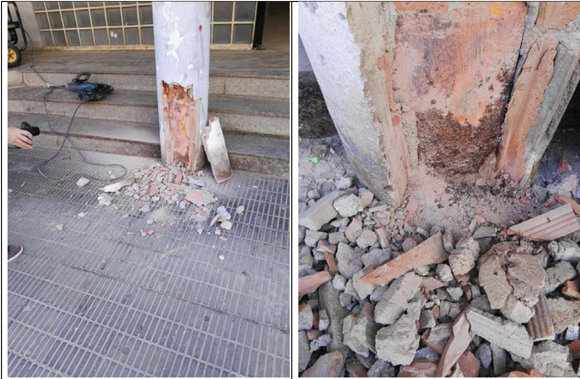
Perspectivas de cata de inspección pilar aislado exterior
