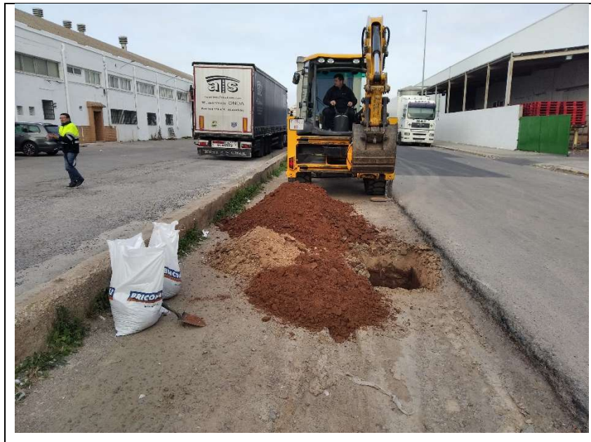
Fotografía 1.- Calicata en zona del vial sin asfaltar.
