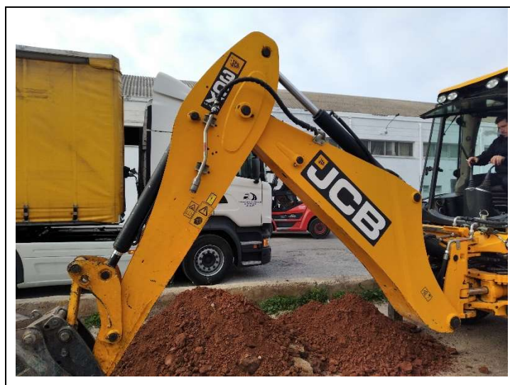
Fotografía 2.- Máquina retroexcavadora utilizada para realización de la calicata.
