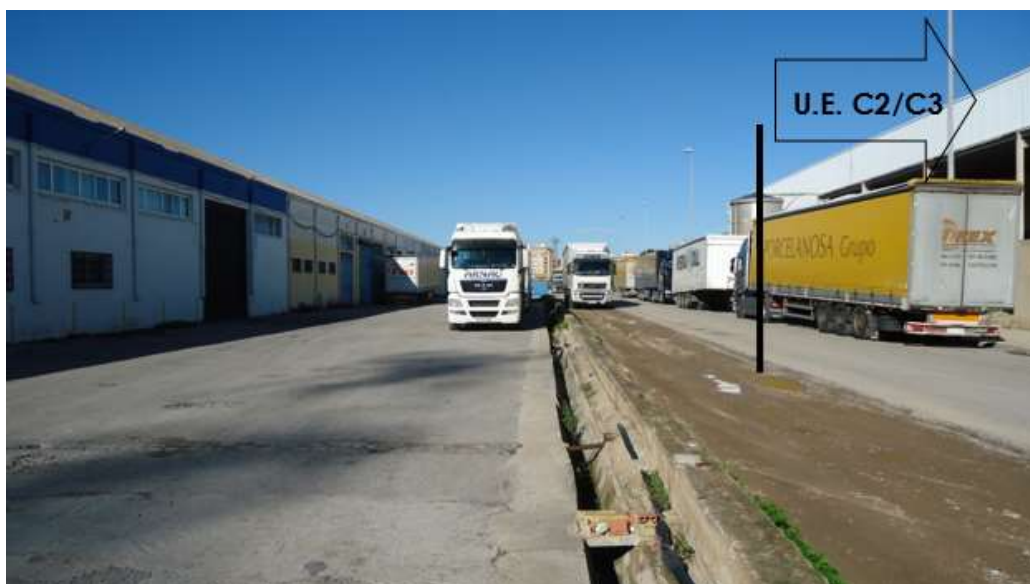
Imagen nº6. Franja de suelo a lo largo del lindero noreste (NE) de la U.E. "Camí Xamussa" con la U.E. C2/C3. De izquierda a derecha en la imagen: Antiguas instalaciones de la mercantil ININSA, vial privado, cuneta para recogida de pluviales, red privada de abastecimiento de agua potable, murete de hormigón límite del vial privado, franja de suelo privado sin pavimentar, y semivial de la unidad de ejecución C2/C3.
