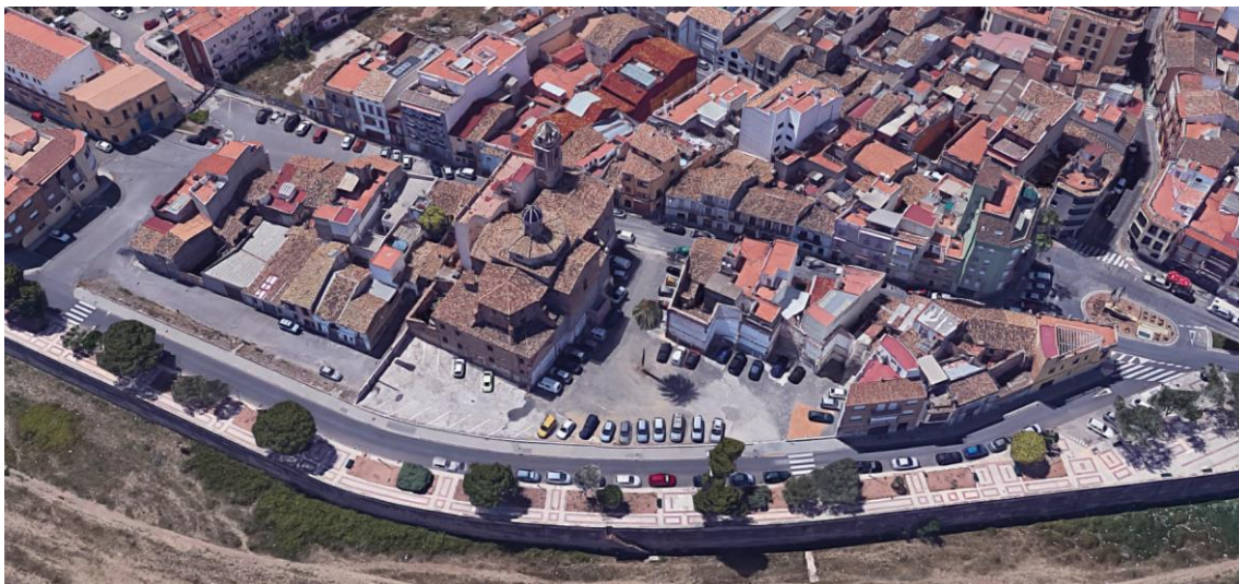
Imagen actual de la zona. Fuente: Google Maps
