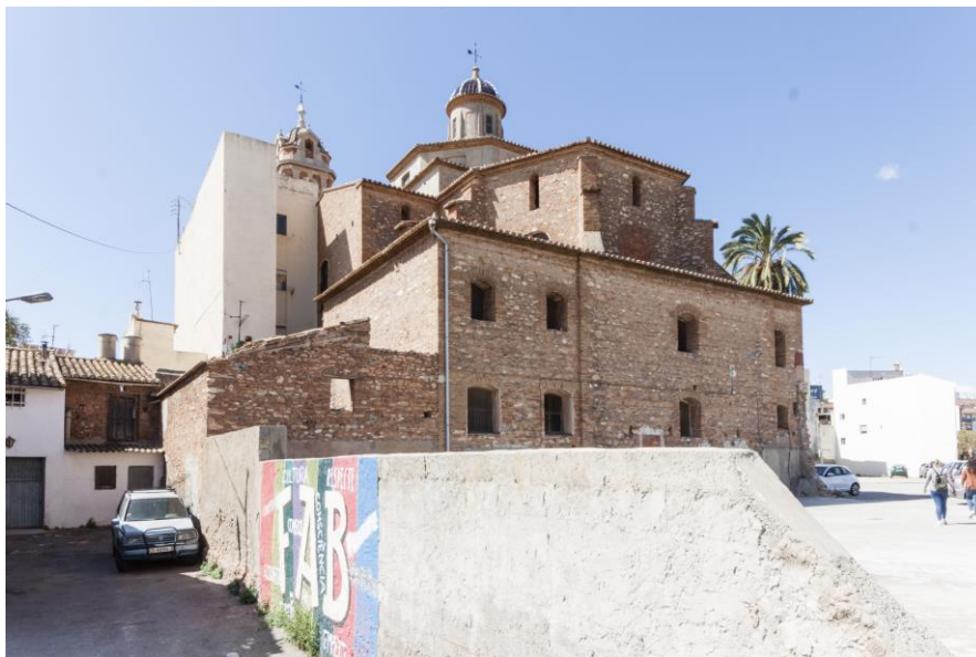
Estado actual de la de la zona posterior de la Iglesia de Sant Blai. Fotografía: El fabricante de esferas, 2018.
