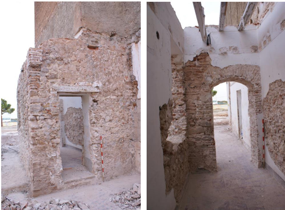
Fotografías de las estructuras encontradas.
