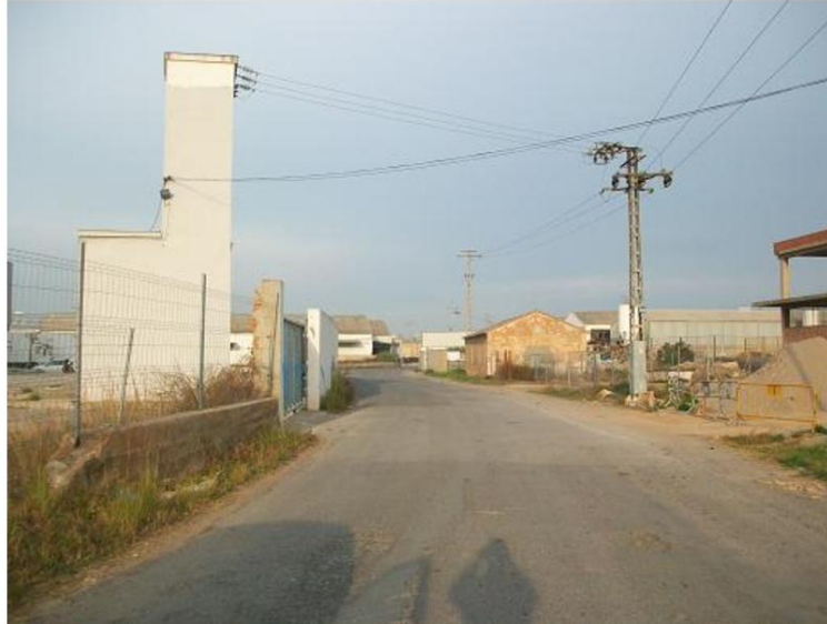
Vista zona a urbanizar (líneas de electricidad, sin aceras...)
