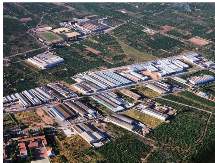
Vista del tejido industrial en el margen de la carretera de Nules
