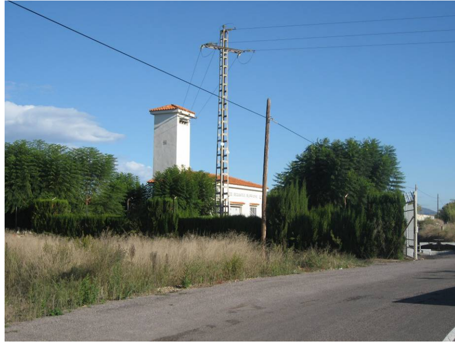
Edificio de la Comunidad de Regantes de Burriana
