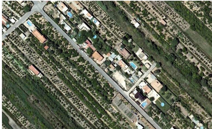
Viviendas existentes en los terrenos inundables de la Marjalera
