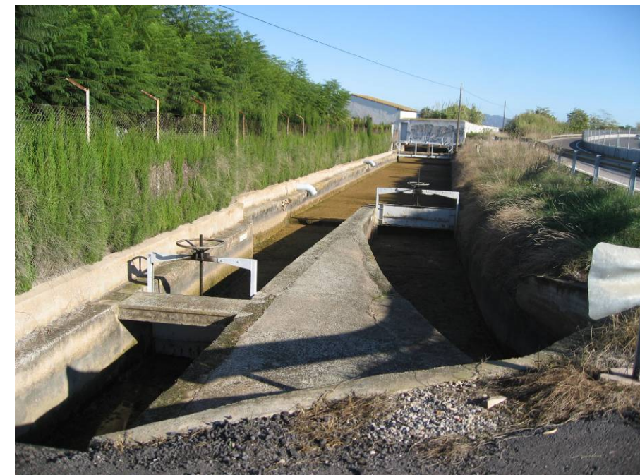
Elementos de la infraestructura hidráulica cercanos al Riu Millars
