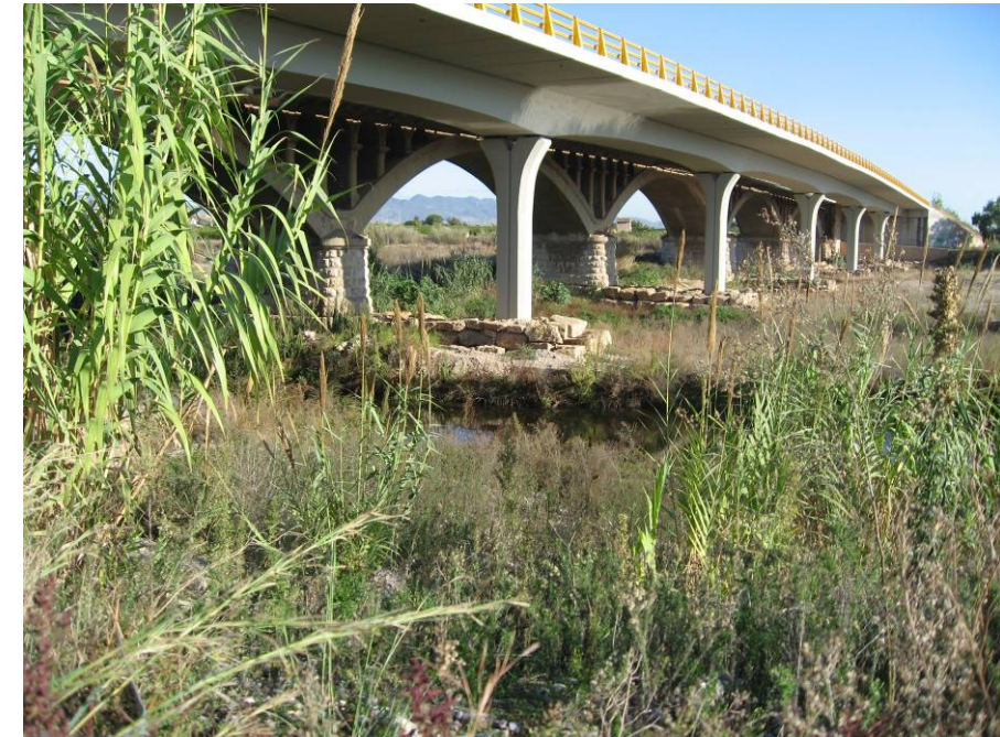
Cruce mediante puente en la CV- 18
