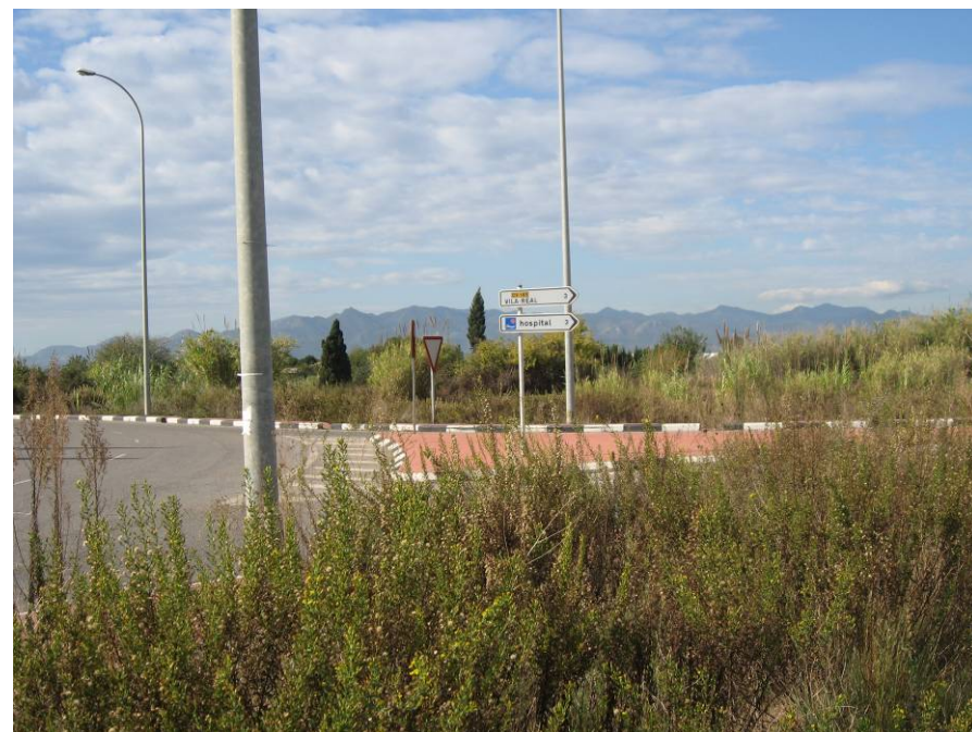
Señalización y entrada a rotondas dentro de la unidad. Elementos de iluminación en las vías principales.
