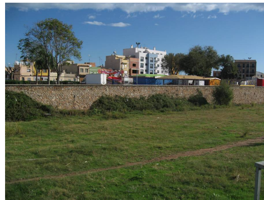
Vista de las edificaciones hacia la parte Norte del Río Anna En este punto es donde se pueden observar los posibles conflictos
