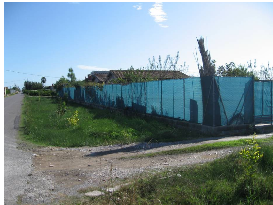
Vista de las construcciones existentes
