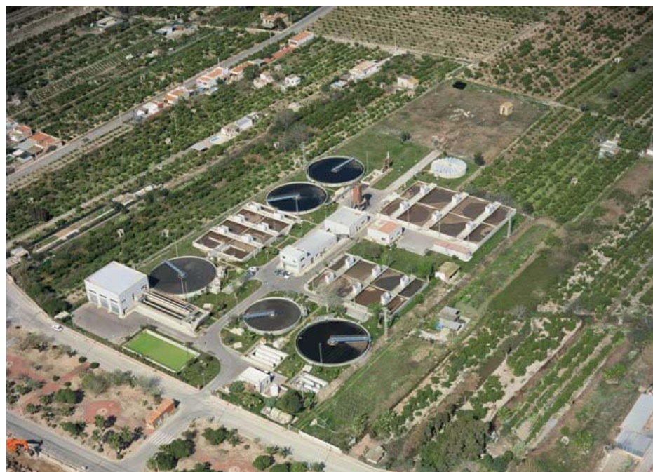
Imagen de la Estación Depuradora de Burriana
