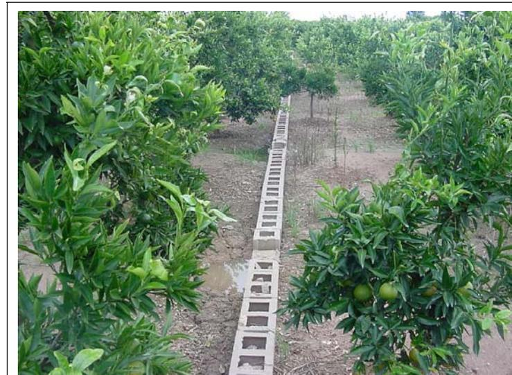
**FOTO N°424:** Murete de separación de bloques de hormigón de 20 cm de ancho.
