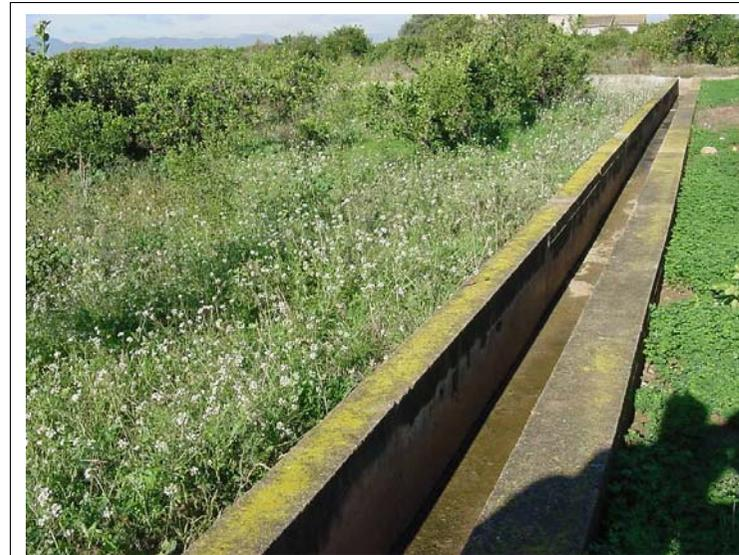
**FOTO N°346: Acequia de 50x60 cm de dimensiones interiores y muros de 20 y 30 cm de ancho en el límite de la urbanización.**
