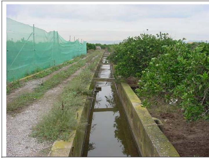
**FOTO N°16:** Acequia de desagüe hacia el Clot de dimensiones interiores 150x100 cm y camino en tierra de 3,5 m de ancho.
