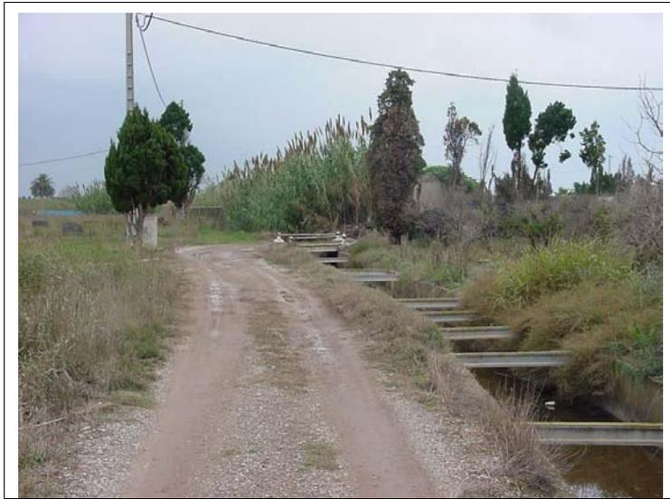
**FOTO N°141:** Camino en tierra de 3 m de ancho. Acequia principal de desagüe.
