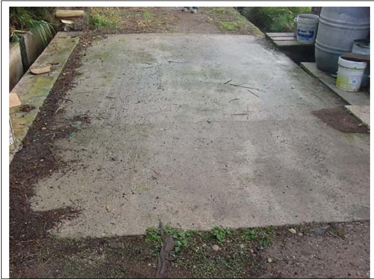
**FOTO N°201: Losa de hormigón de dimensiones 3.20x5.60 m.**
