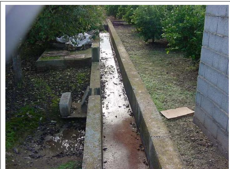
**FOTO N°291: Acequia de dimensiones interiores 60x40 , murete de 20 cm y losa de hormigón de 2x2 m**
