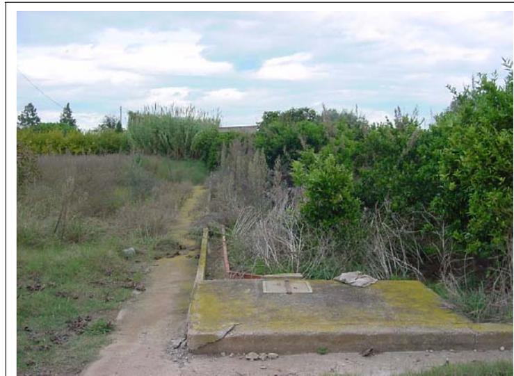
**FOTO N°436: Alberca y acequia de 25x20 con muros de 8 y 4 cm.**
