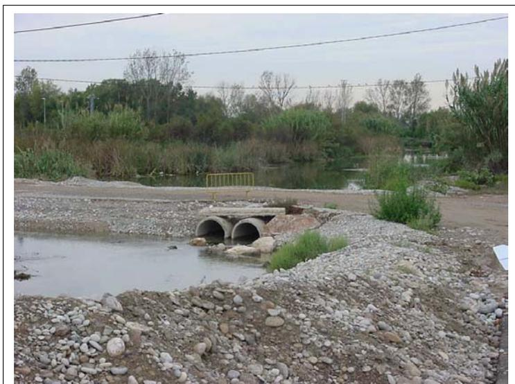
**FOTO N°1:** Desagüe al mar aguas del Clot Mare de Dèu con dos tubos de hormigón de diámetro 1000 mm.
