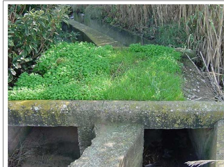
FOTO N°282: Losa de hormigón de 1,4x 3 m
