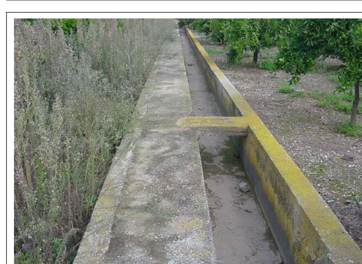
**FOTO N°536: Acequia de 70x70 cm y muros de 90 y 20 cm de ancho.**
