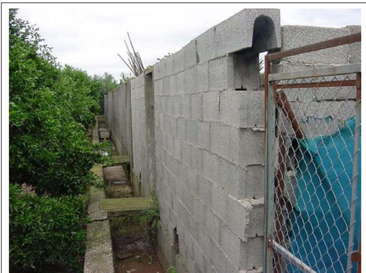
**FOTO N°29: Muro conformado por bloques de hormigón de 3 m de altura.**
