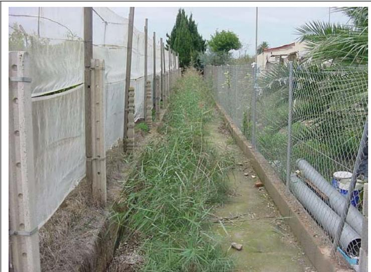
**FOTO N°155: Acequia de 70x60 cm. Losa de hormigón de 1.20 m de ancho. Vallas metálicas de 2.00 y 2.50 m de altura con soportes de hormigón.**
