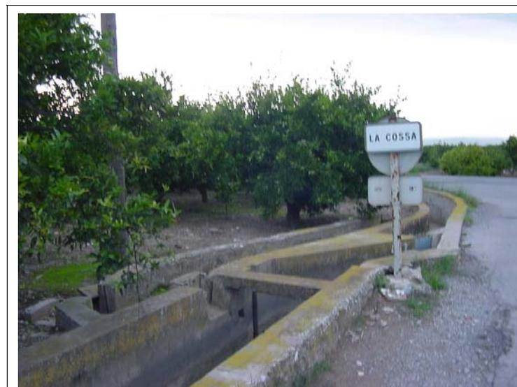
**FOTO N°582:** Cambio de sección de dos acequias. Poste telefónico.
