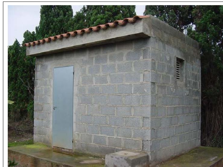
**FOTO N°110: Caseta para cabezal de riego por goteo.**
