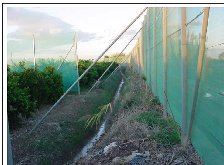
**FOTO N°460: Acequia de 3 m de ancho y 1.5 m de calado. Cerramiento de 4 m.**
