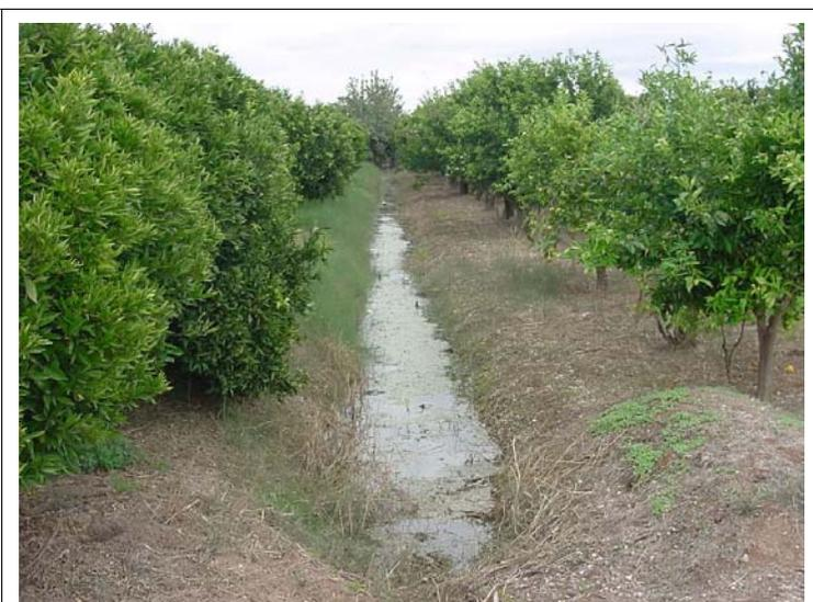
**FOTO N°431:Acequia de 1.5 m de ancho y 50 cm de profundidad.**
