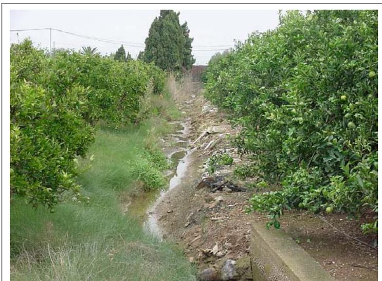
**FOTO N°119:** Acequia de drenaje en tierra de 40 cm de profundidad.
