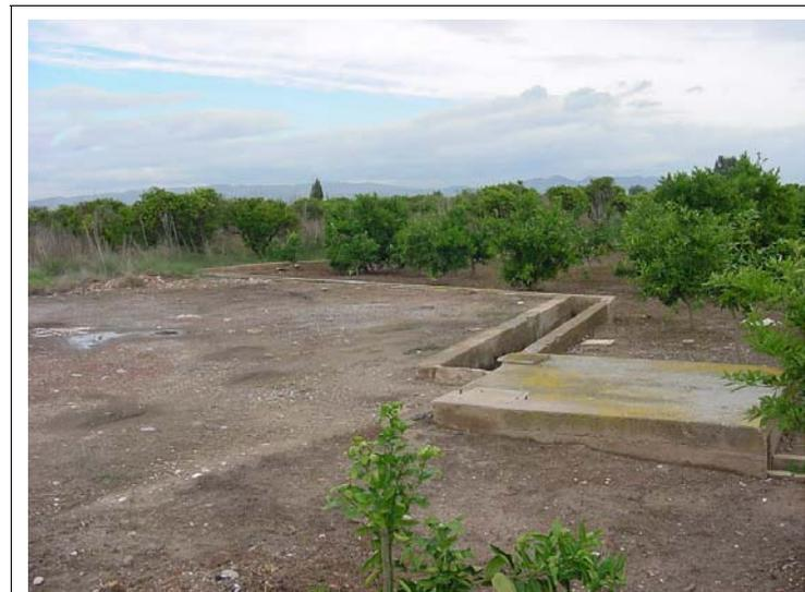
**FOTO N°412:** Alberca de 2x2 m y acequia de 50x40 cm con muros de 20 cm de ancho.
