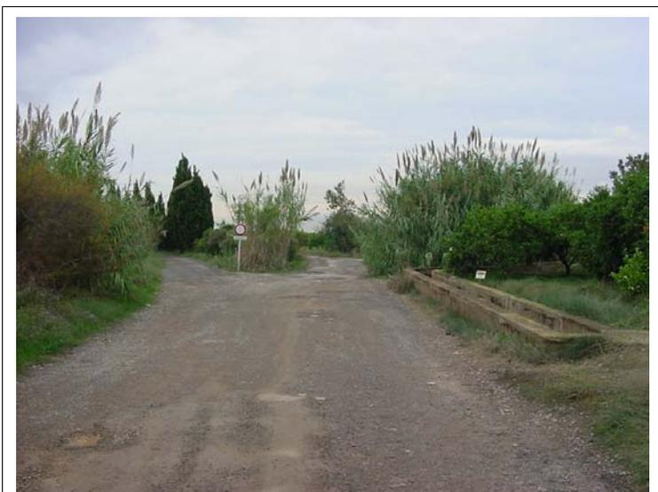
**FOTO N°5:** Camino en tierra estabilizado con gravilla y acequia de riego de dimensiones interiores 75x60 cm.
