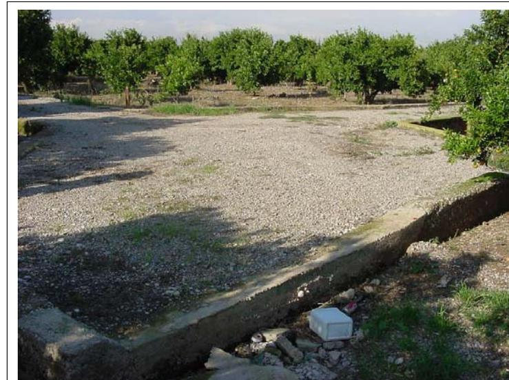
**FOTO N°286:** Explanada delimitada por murete de 30 cm de ancho y 40 cm de alto.
