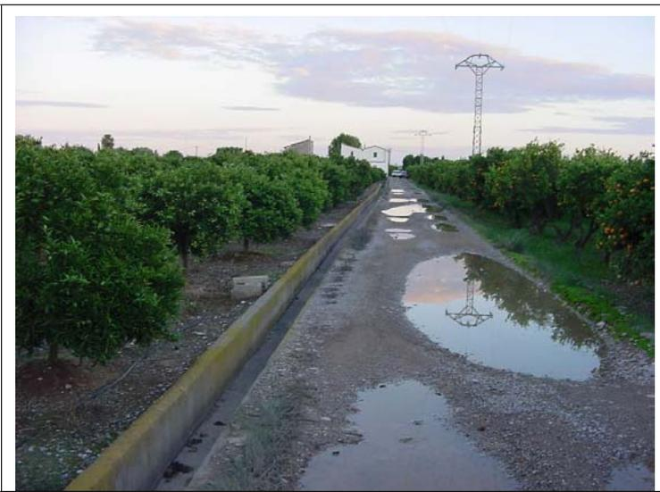
**FOTO N°463:Camino de tierra con acequia de 40x30 con muros de 10 y 20 cm.**
