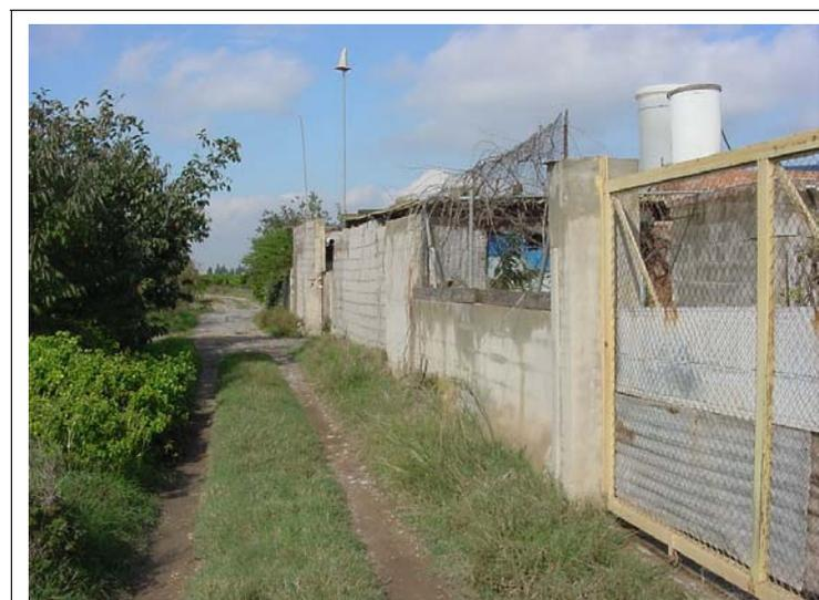
**FOTO N°244: Edificaciones de una altura. Cerramiento formado por bloques de hormigón de 2 m de altura.**
