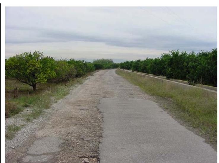
**FOTO N°23: Camino pavimentado de 6 m de ancho y acequia elevada sobre el camino.**
