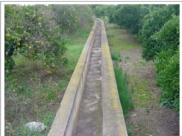
**FOTO N°569: Acequia de 50x50 cm y muros de 20 y 30 cm de ancho.**
