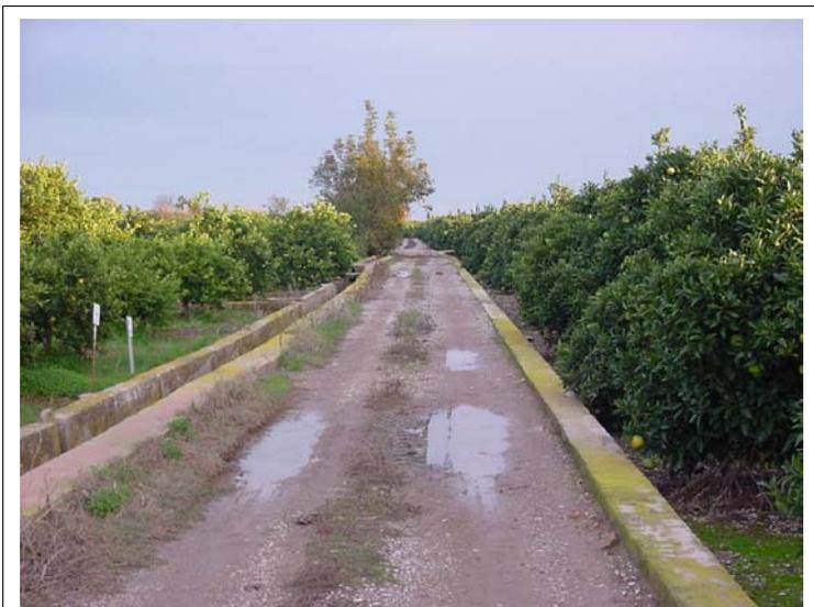
**FOTO N°329:** Camino en tierra de 3.5 m de ancho delimitado por una acequia de 55x60 cm y muros de 20 y 45 cm de ancho y un murete de 30x30 cm en el límite de la urbanización.
