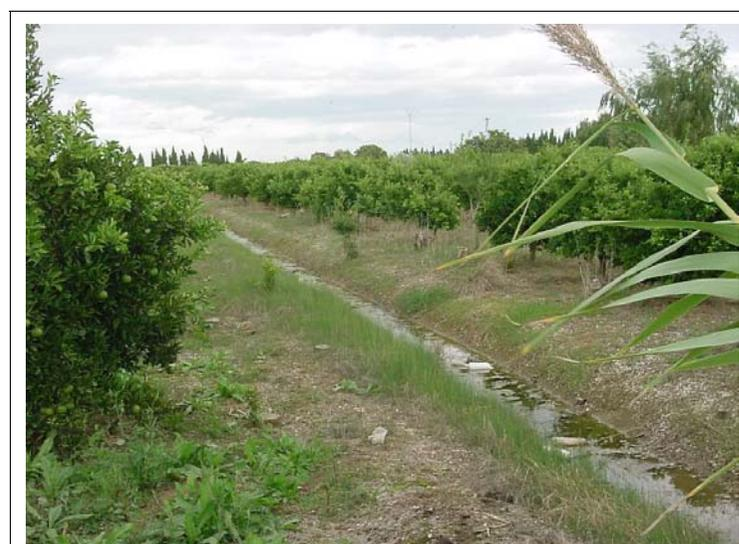
**FOTO N°428: Acequia excavada en tierra de 1.5 m de ancho y 50 cm de calado.**
