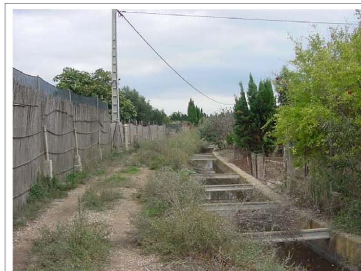
**FOTO N°66: Camino en tierra de 4 m de ancho y acequia de drenaje de dimensiones interiores 200x100 cm.**
