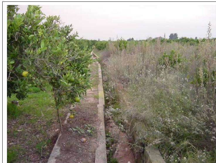
**FOTO N°338:**Acequia de 50x60 cm con muros de 15 cm de ancho.
