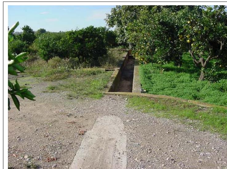
**FOTO N°482: Losa de 6.0x0.7 m. Dos acequias de dimensiones interiores 70x50 y 50x40 cm.**
