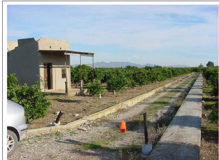
**FOTO N°472: Edificación de una altura. Camino en tierra con murete de 20x40 cm , losa de 100x25 cm y acequia bajo la losa de 40x30 cm.**
