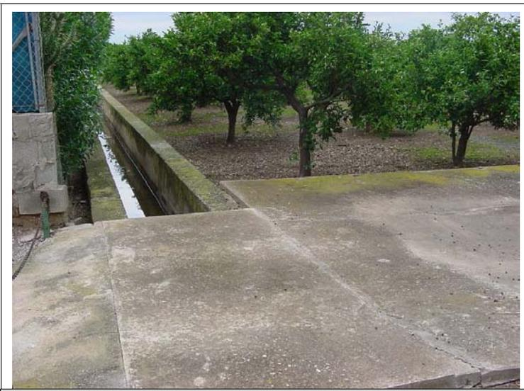
**FOTO N°55:** Losa de hormigón de 15 cm de espesor.
