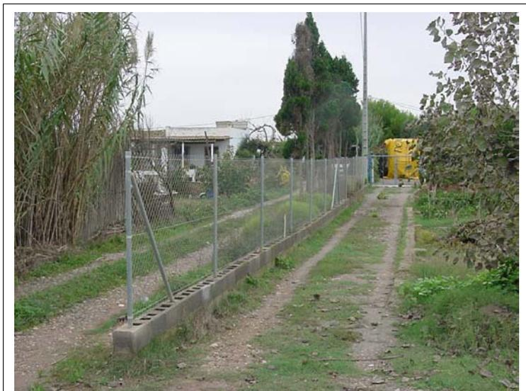
**FOTO N°81:** Camino en tierra y cerramiento formado por bloques de hormigón de 20x40 cm con valla metálica de 2 m y casa de una altura.
