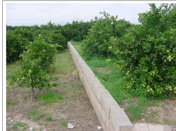
**FOTO N°526: Murete de bloques de hormigón de dimensiones 20x60 cm en el límite de la urbanización.**
