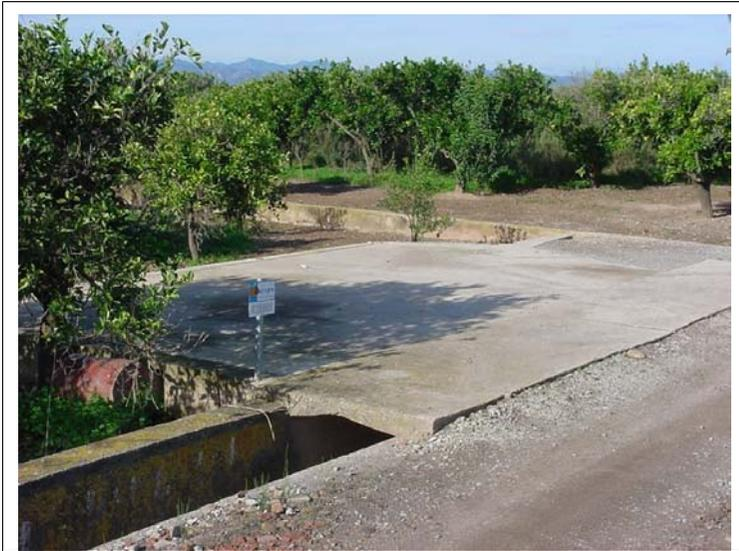
**FOTO N°485:** Losa de dimensiones 6.0x4.0x0.4 m y murete de 30x30 cm.
