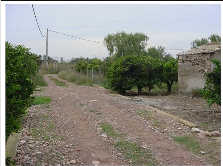
**FOTO N°157:** Camino delimitado por muretes de hormigón de 20x30 cm. Edificación de una altura. Cerramiento metálico. Poste eléctrico.
