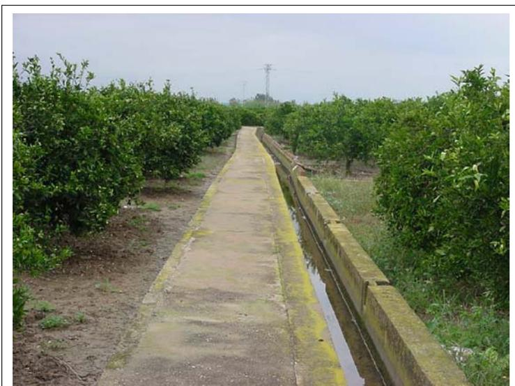
**FOTO N°121: Losa de hormigón de 1.40 m de ancho y 30 cm de espesor. Acequia de 55x55 cm.**
