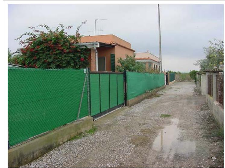
**FOTO N°130: Edificaciones de una altura con cerramiento formado por murete de hormigón y valla metálica.**
