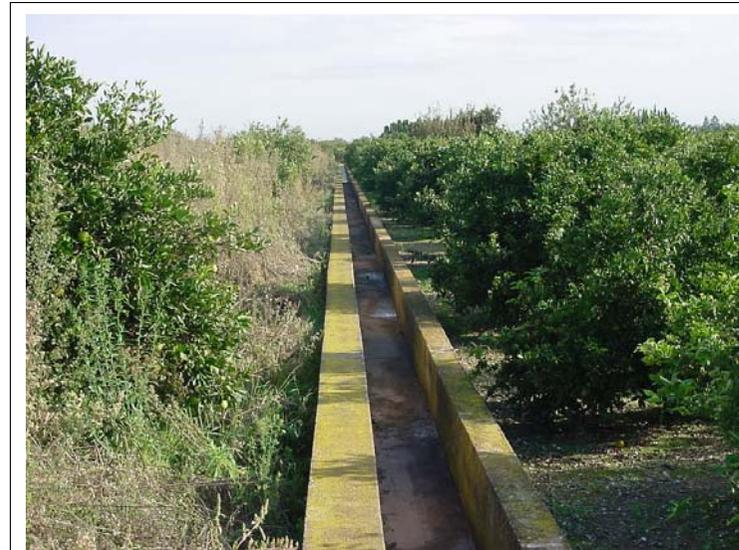
**FOTO N°290: Acequia de 60x40 y muros de 40 y 20 cm de ancho.**
