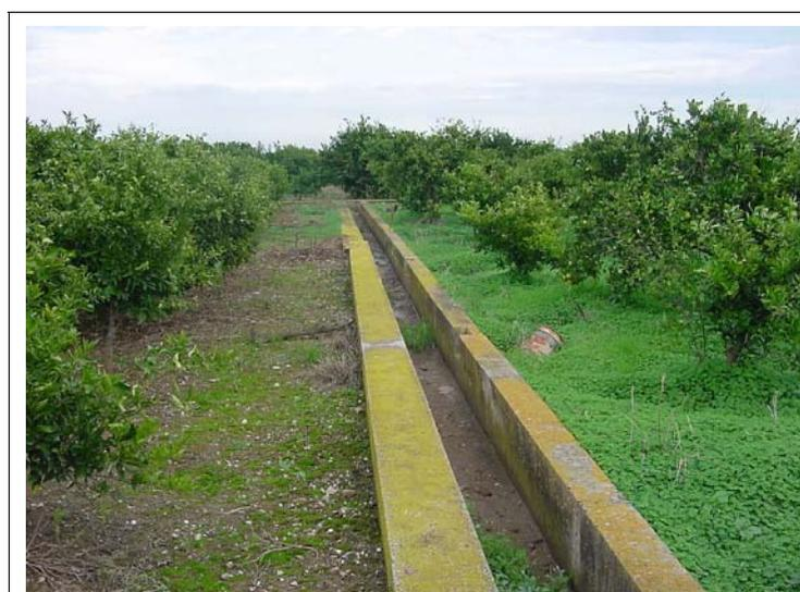
FOTO N°300: Acequia de 45x50 y muretes de 20 y 30 cm de ancho.
