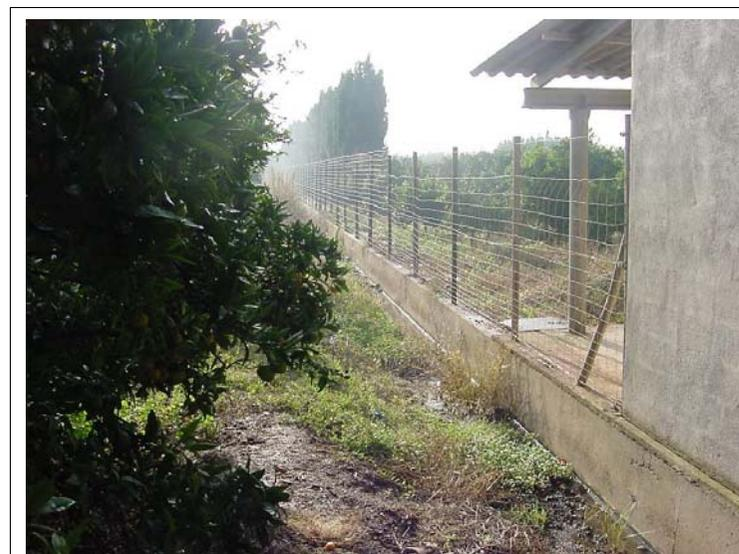
**FOTO N°206: Cerramiento formado por muro de hormigón de 0.5 m de altura y valla metálica. Acequia con un muro de hormigón y otro en tierra.**
