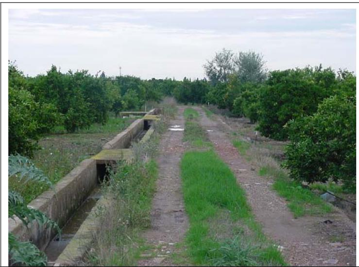
**FOTO N°319: Acequia de 55x65 con muros de 20 cm junto a camino de tierra delimitado con bordillos de 20x20 y alberca de 2x2 m.**
