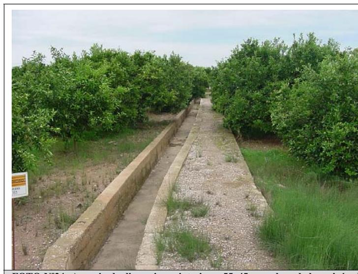
**FOTO N°24: Acequia de dimensiones interiores 55x45 cm y losa de hormigón de 1.5 x0.25 m .**
