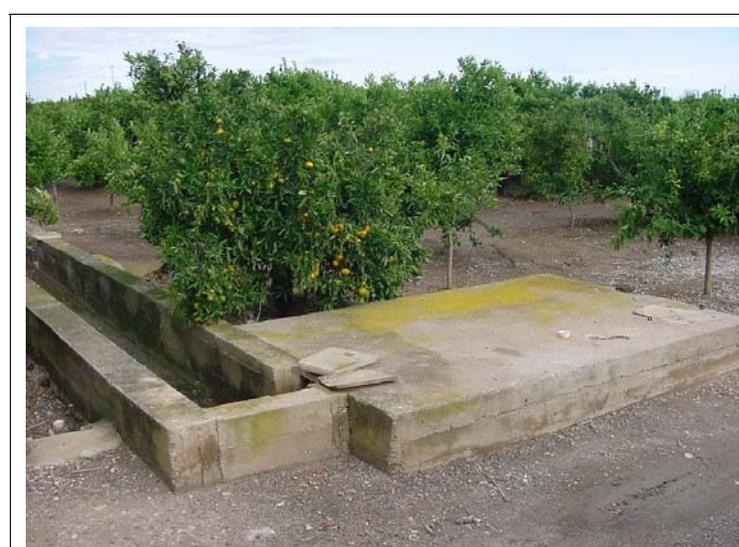
**FOTO N°420: Alberca de 3x2 m y acequia de 60x50 cm con muros de 30 y 20 cm de ancho.**
