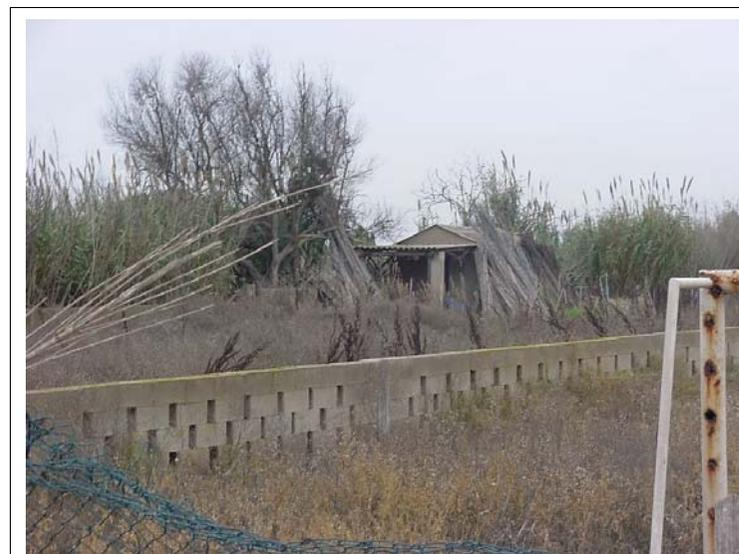
**FOTO N°170: Edificación de una altura. Dos muros de bloques de 1.50 m de altura.**
