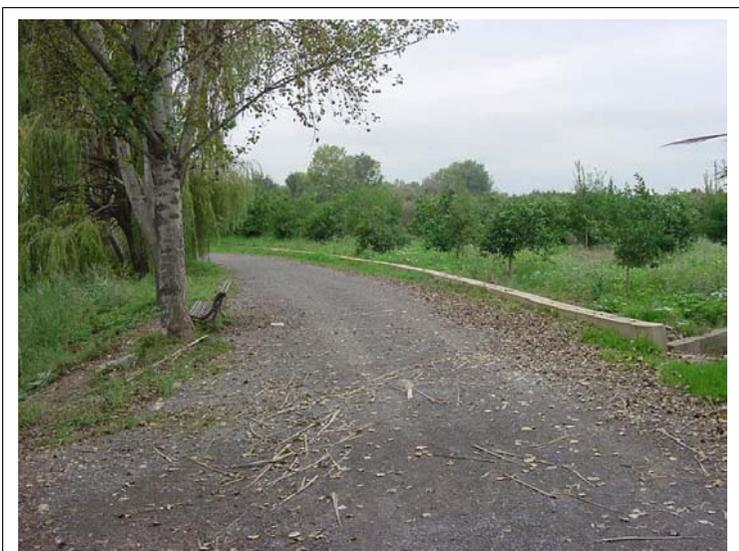
**FOTO N°21: Camino en tierra estabilizado con gravilla de 4 m de ancho.**
