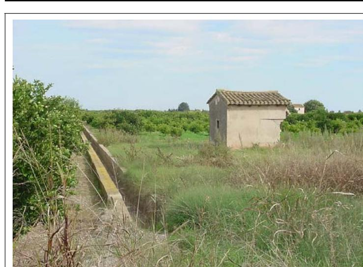
**FOTO N°528: Acequia de dimensiones interiores 50x40 cm y edificación de una altura.**
