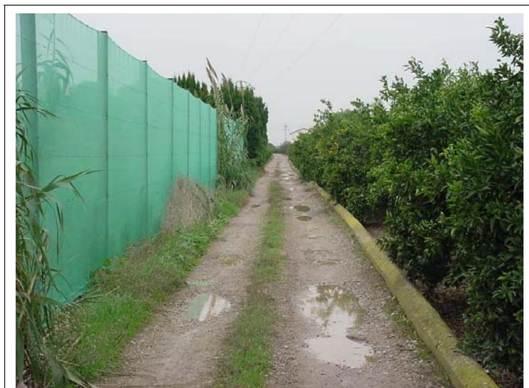
**FOTO N°99: Camino en tierra de 2.40 m de ancho con murete de hormigón de 30x50 cm. Vallado de 3.5 m de altura.**
