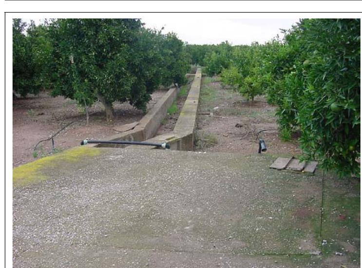
**FOTO N°308: Acequia de dimensiones interiores 80x60 con muretes de 40 y 20 cm de ancho. Alberca de 3.2x3.2 m.**
