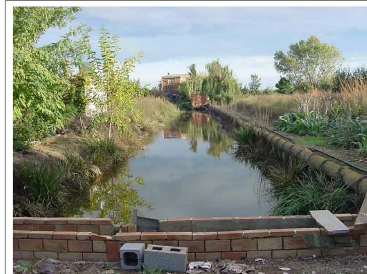
**FOTO N°446:**Acequia excavada en tierra de 8 m de ancho y 1.5 m de calado. En el margen derecho discurre tubería de hormigón y al fondo vivienda de 2 alturas.
