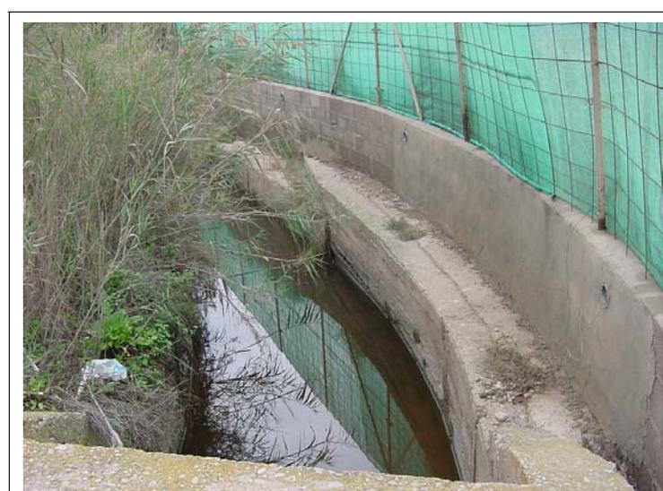
**FOTO N°72:** Acequia de drenaje, murete de bloques de hormigón de 1 m de altura y valla metálica.
