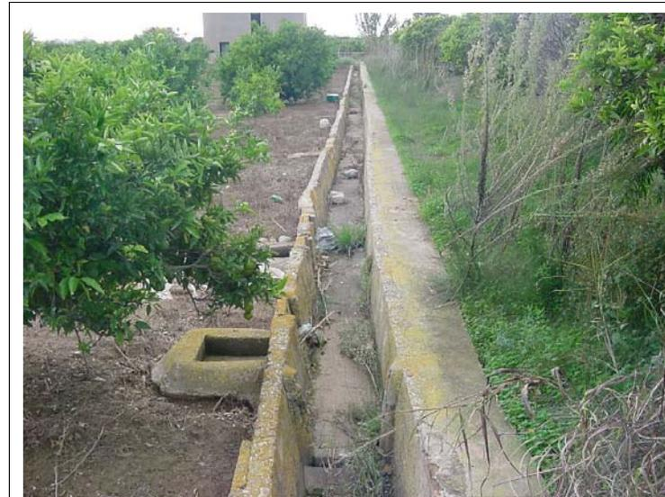
**FOTO N°422:** Acequia de 60x60 cm con muros de 20 y 40 cm de ancho.
