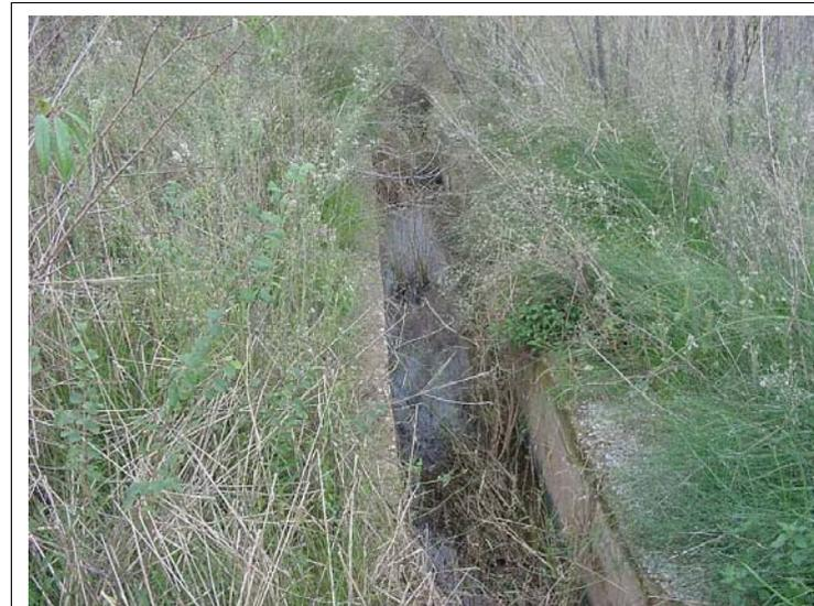
**FOTO N°442: Acequia de 60x60 con muros de 30 cm de ancho.**
