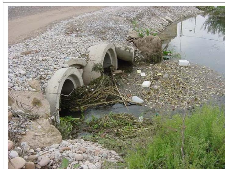
**FOTO N°2:** Tubos de hormigón para desaguar las aguas del Clot Mare de Dèu.
