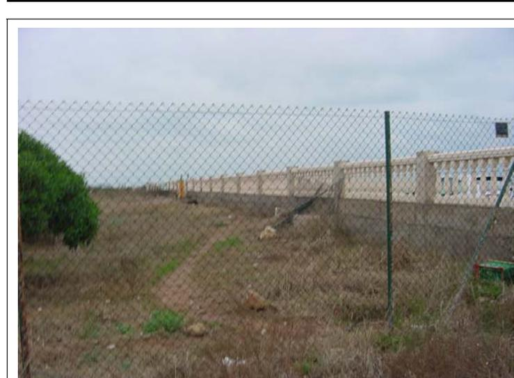
**FOTO N°184:** Cerramiento formado por valla metálica y muro de hormigón.
