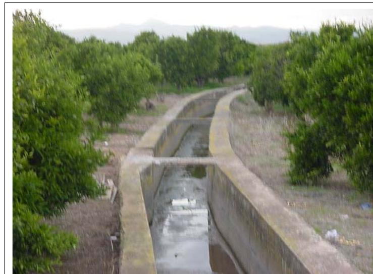
**FOTO N°584:** Acequia de 120x100 cm y muros de 30 y 40 cm de ancho en el límite de la urbanización.
