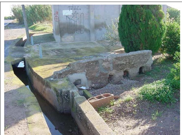
**FOTO N°343: Límite de urbanización. Acequia de 70x60 cm con muros de 30 y 20 cm de ancho y caseta de 1 altura.**
