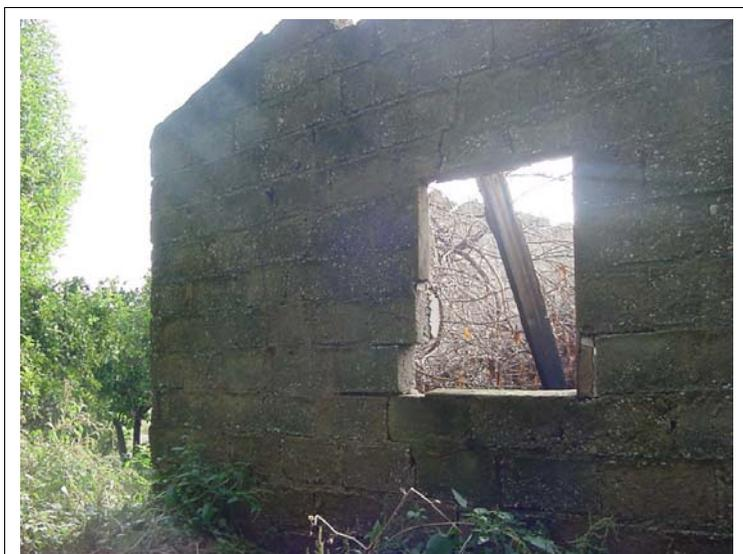
**FOTO N°205: Edificación de bloques de hormigón de 2.5 m de altura.**
