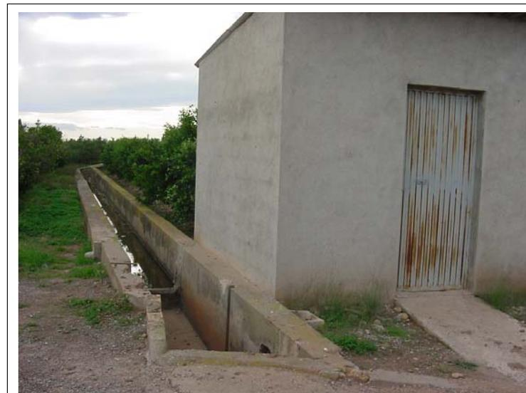
**FOTO N°558:** Acequia de 75x80 cm y muros de 40 y 30 cm de ancho en el límite de la urbanización. Edificación de una altura.
