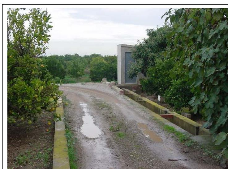
**FOTO N°304: Camino de tierra con murete de 30x20 en un lateral y caseta de una altura y acequia de 45x50 (con muretes de 25 cm) en el otro.**
