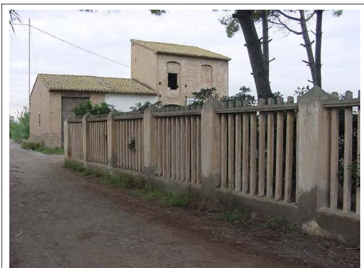
**FOTO N°3:** Cerramiento de vivienda en hormigón de 2 m de altura.
