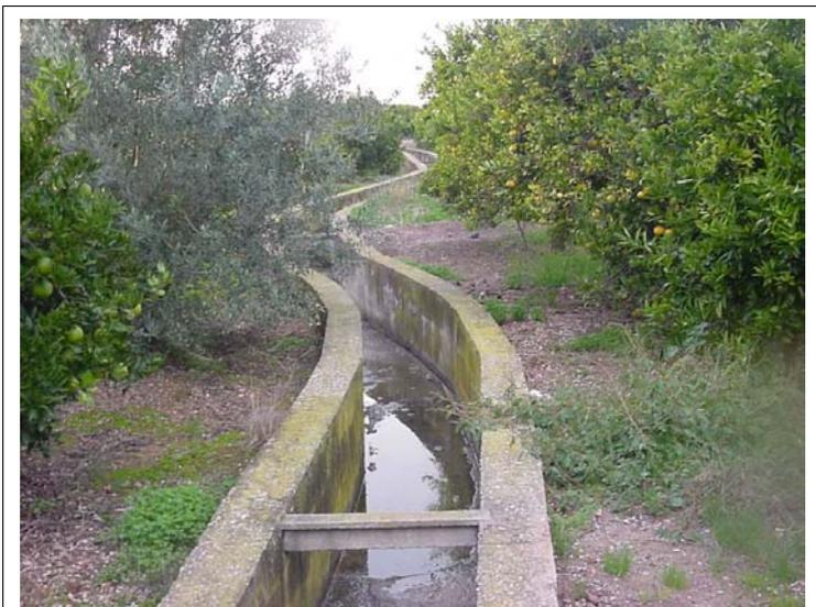
**FOTO N°325: Acequia de dimensiones interiores 80x80 y muros de 30 cm de ancho en el límite de la urbanización.**
