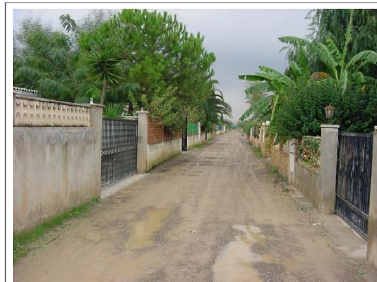
**FOTO N°134: Cerramientos de viviendas de 2 m de altura de hormigón y de murete de hormigón de 0.50 m con valla metálica.**
