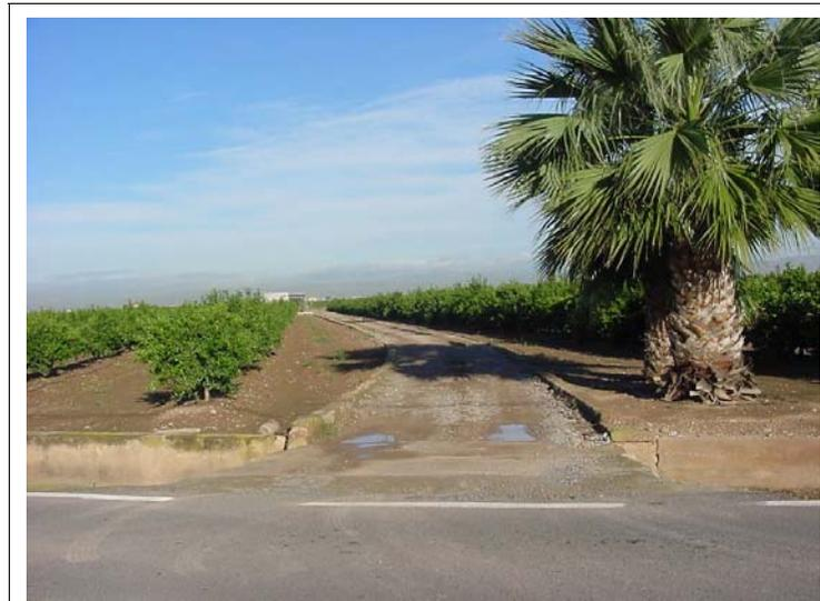
**FOTO N°344: Camino de tierra de 3 m de ancho con muretes de hormigón a ambos lados en el límite de la urbanización.**
