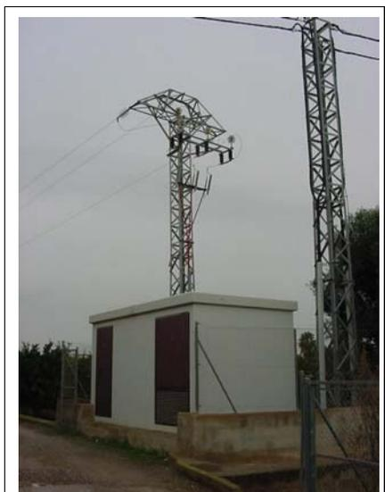
**FOTO N°97: Centro de Transformación de dimensiones 4.8 x 3 m.**
