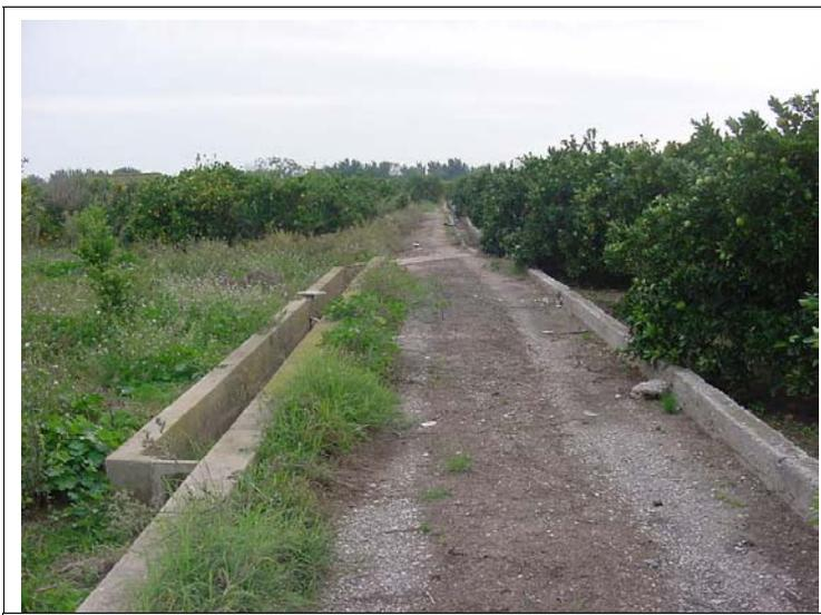
**FOTO N°643: Camino en tierra de 2.5 m de ancho bordeado por dos acequias de dimensiones interiores 60x50 cm.**
