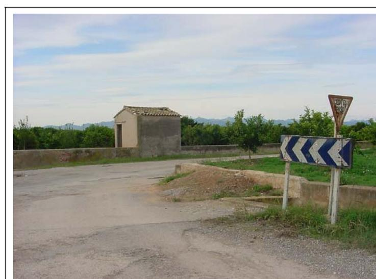
**FOTO N°512: Edificación de una altura. Carretera bordeada por muro de 1.2 m de altura y acequia de dimensiones interiores 1.0x1.0 m.**
