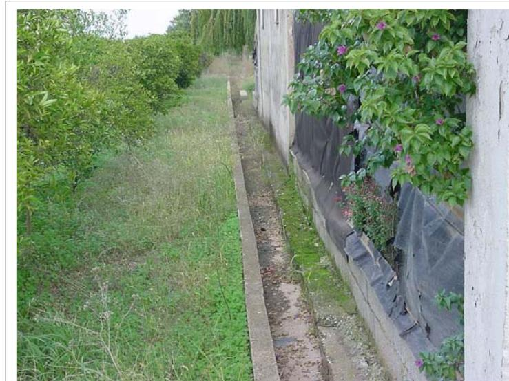
**FOTO N°434: Acequia de 30x20 cm y muros de 10 y 30 cm de ancho.**
