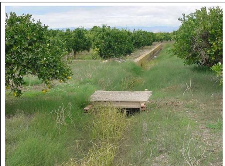
**FOTO N°419: Acequia excavada en tierra y losa de hormigón apoyada sobre muretes de ladrillo.**
