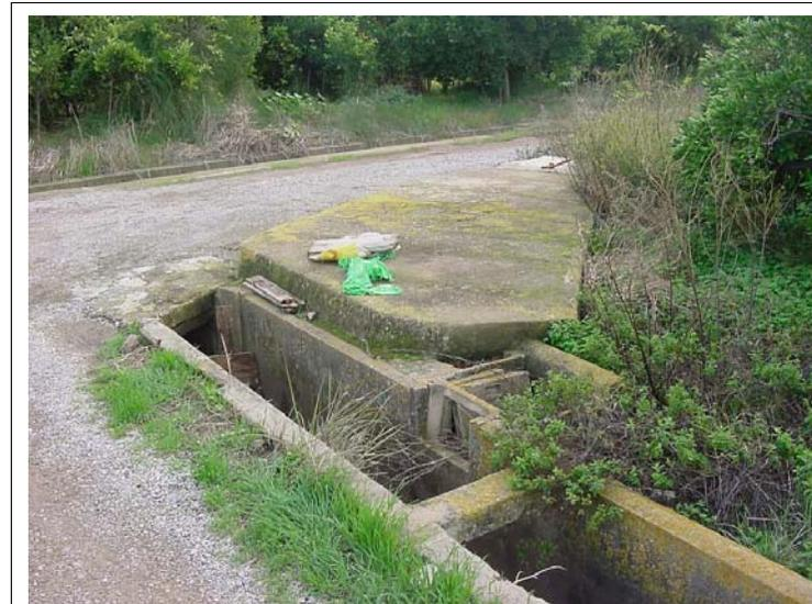
**FOTO N°294: Acequia de dimensiones interiores 50x70 con muros de 10 cm y alberca de 4x2 m.**
