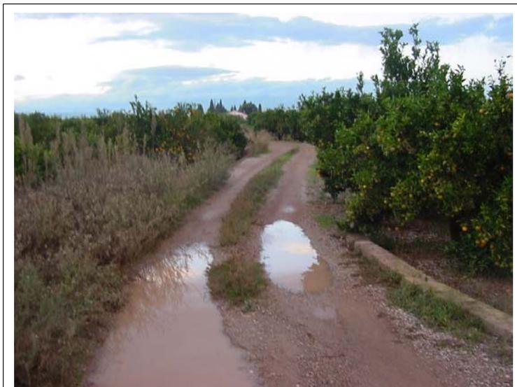
**FOTO N°337:**Límite de la urbanización. Camino de 3.5 m de ancho, acequia de 50x60 cm con muros de 15x15 y murete de 20x30
