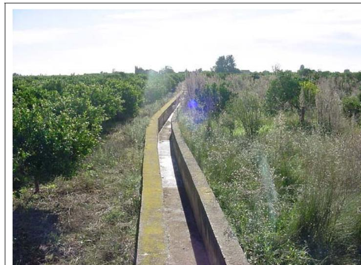
**FOTO N°348: Acequia de 50x60 con muros de 20 y 30 cm de ancho.**
