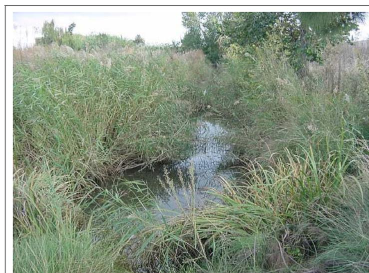
**FOTO N°444: Acequia excavada en tierra de 4 m de ancho y 1.5 m de calado.**
