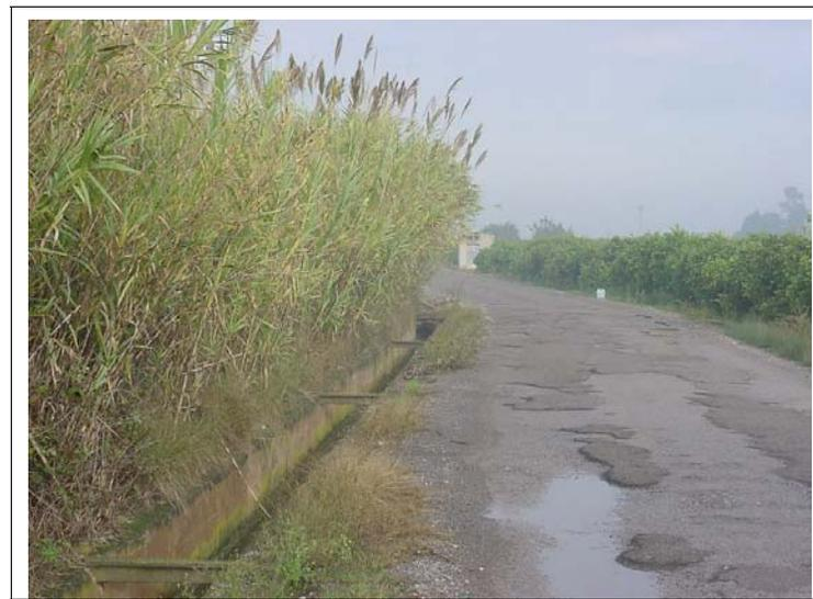
**FOTO N°200: Acequia de 80x80 cm. Camino pavimentado de 5 m. Edificación de una altura.**
