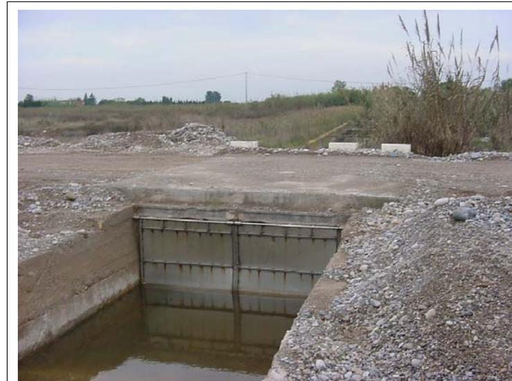
**FOTO N°182:** Desagüe al mar. Muros de 1.5 m de altura. Losa que cubre el camino de 4.80 m de ancho.
