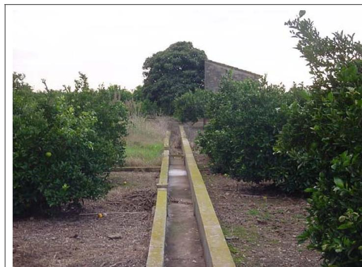
**FOTO N°332:** Acequia de 50x30 cm con muros de 20 cm de ancho. Murete perpendicular a acequia de 20x20 cm y edificación al fondo de una altura.
