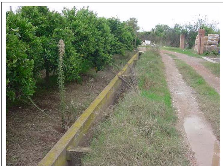
**FOTO N°437:** Acequia de 50x60 con muros de 20 cm junto a camino de tierra.
