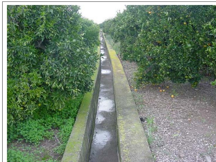
**FOTO N°302: Acequia de dimensiones interiores 50x50 y muretes de 20 y 40 cm de ancho.**
