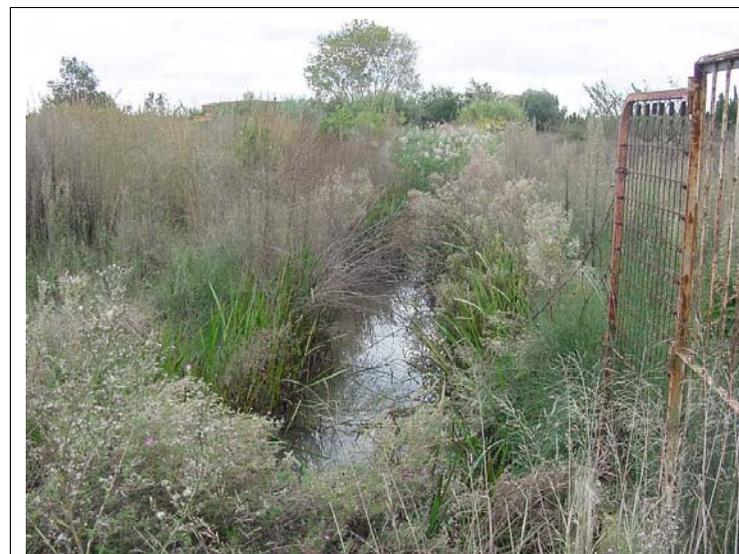
**FOTO N°438:** Acequia excavada en tierra de 3 m de ancho y 1.5 m de calado.
