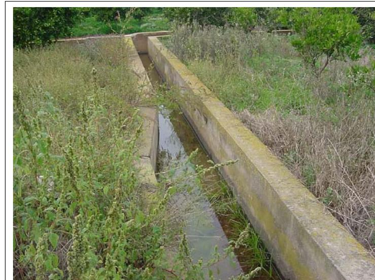
**FOTO N°322: Acequia de 60x50 con muretes laterales de 30 cm de ancho.**
