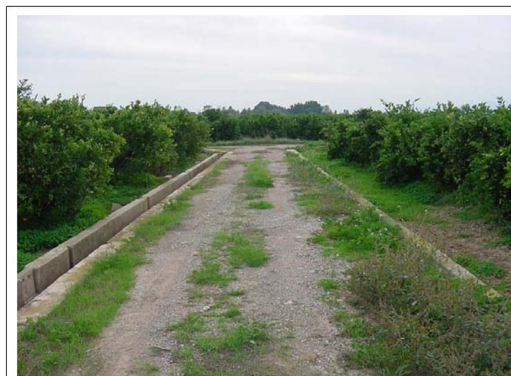
**FOTO N°632: Camino en tierra de 3.5 m de ancho bordeado por una acequia de dimensiones interiores 50x50 cm y un murete de 20x30 cm en el límite..**
