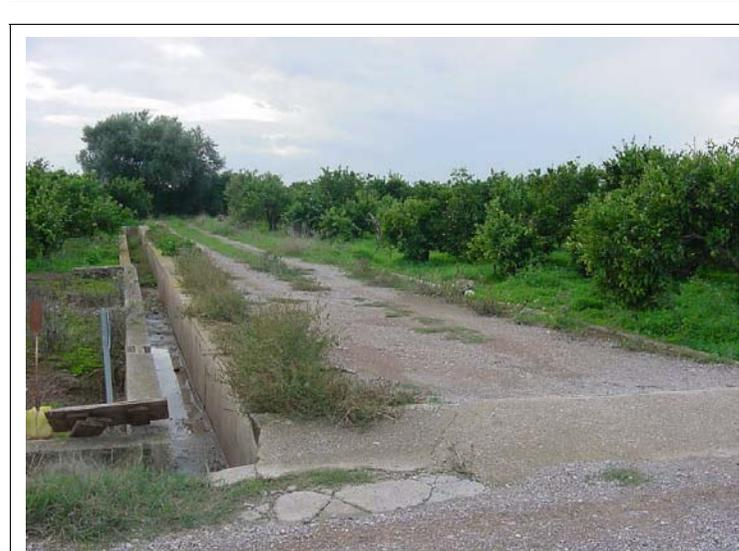
**FOTO N°296: Camino de tierra bordeado de muretes de hormigón de 20x20 cm. Losa de hormigón de 5.6x1.2 m.**
