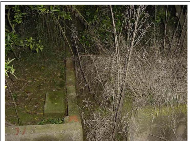
**FOTO N°341: Acequia de 50x30 cm con muros de 15 cm de ancho.**
