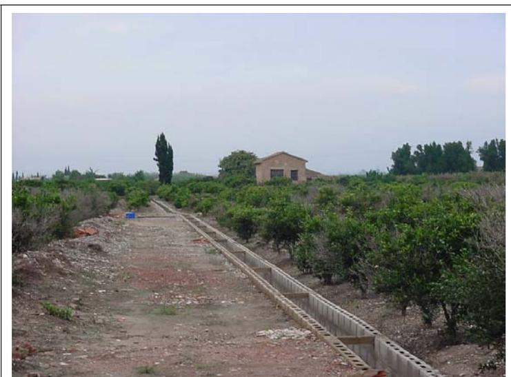
**FOTO N°187: Acequia en bloques de hormigón de dimensiones interiores 45x60 cm. Edificación de dos alturas.**
