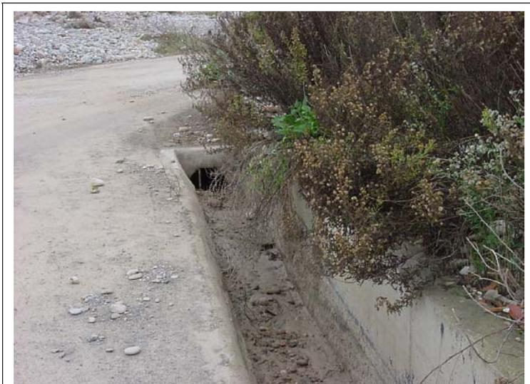
**FOTO N°39: Drenaje del camino por su cuneta y obra de paso para el desagüe al mar.**
