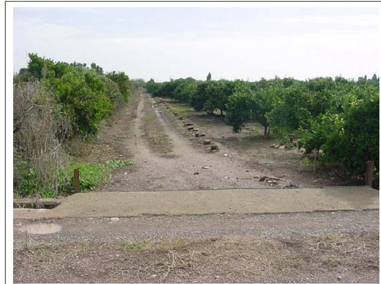
**FOTO N°258: Camino en tierra y losa de hormigón de dimensiones 4.0x1.6 m.**
