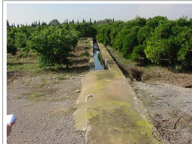
**FOTO N°222: Losa de hormigón de dimensiones 1.2x12.0 m.**
