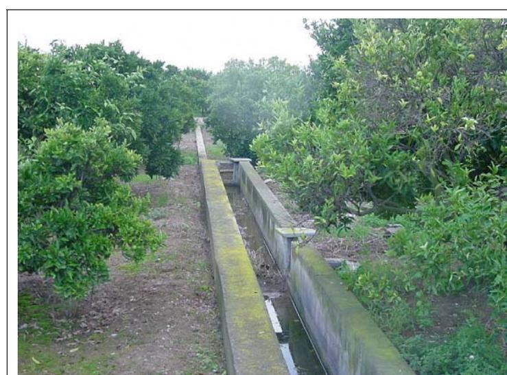
**FOTO N°316:**Acequia de 50x60 cm con muretes de 20 y 30 cm de ancho y 15 cm de alto. Murete de separación de 20x15 cm.
