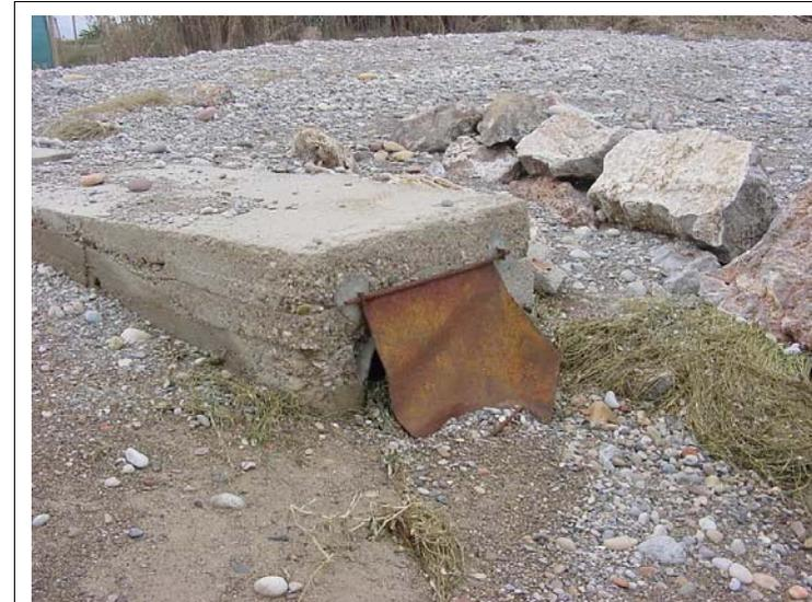
**FOTO N°42: Tubo de desagüe al mar de 1 m de diámetro y tapa para evitar la entrada de agua de mar.**
