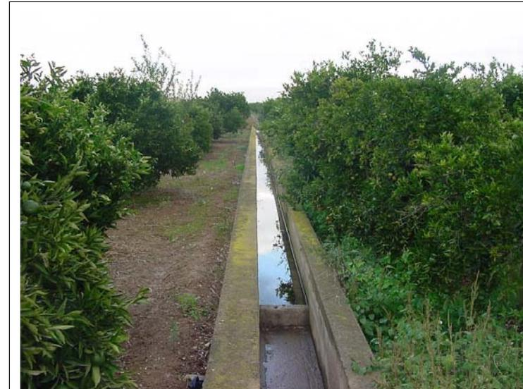
**FOTO N°318: Acequia de 50x60 con muros laterales de 30 y 20 cm de ancho.**
