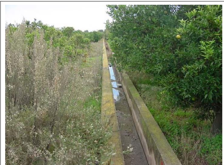
**FOTO N°403:Acequia de 50x50 cm con muros de 30 y 20 cm de ancho.**
