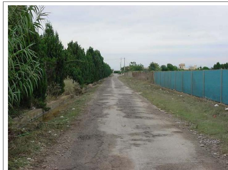
**FOTO N°38: Camino pavimentado de 4 m de ancho y cerramiento con murete de hormigón y valla metálica de 2 m.**
