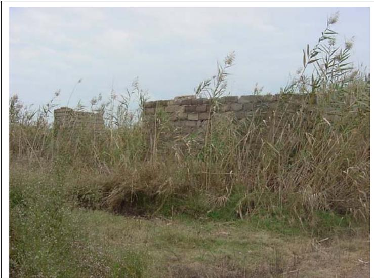
**FOTO N°177: Muros de bloques de hormigón de 2.50 m de altura.**
