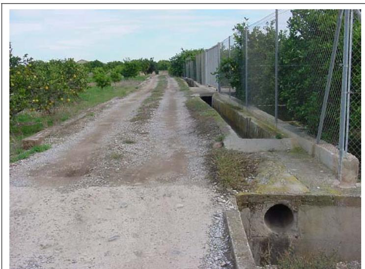
**FOTO N°519:** Límite de la urbanización con camino de 3 m de ancho, murete de 20x20 cm, acequia de 50x50 cm y cerramiento formado por valla metálica de 2 m de altura y murete de 20x50 cm.
