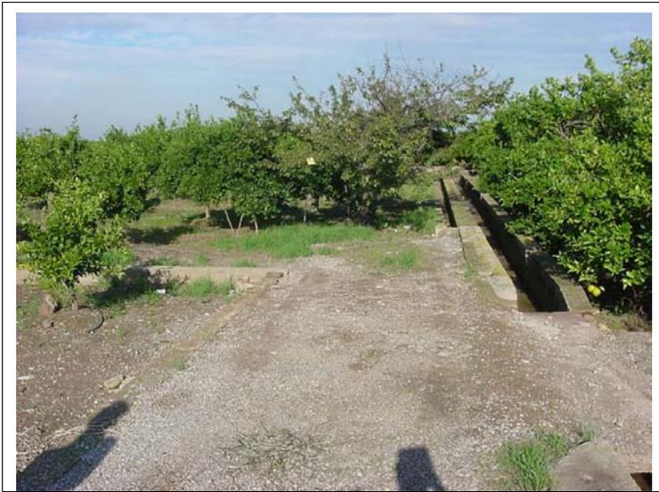
**FOTO N°285:** Acequia de dimensiones interiores 60x60 y murete de 20x30. Camino de tierra de aproximadamente 2.5 m de ancho.
