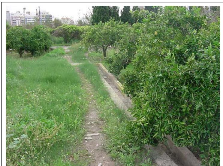
**FOTO N°9:** Camino en tierra de 2 m de ancho y acequia de riego de 30 cm de calado.
