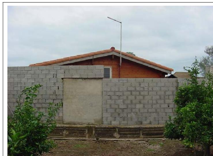
**FOTO N°32: Casa prefabricada de 4 m de altura y cerramiento con bloques de hormigón.**
