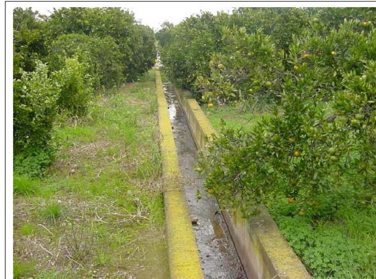
**FOTO N°310: Acequia de 50x60 y muretes de 20 cm de ancho.**
