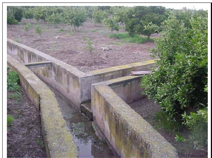
**FOTO N°327: Acequia principal de drenaje de 80x80 cm con muros de 25 y 30 de ancho y acequia lateral de 50x60 en el límite de la urbanización.**
