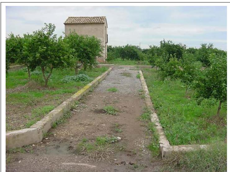
**FOTO N°13:** Camino en tierra delimitado por muretes de hormigón de 20 cm de altura.
