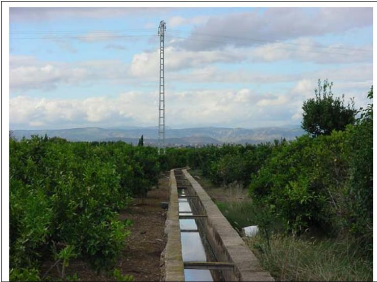
**FOTO N°421:** Acequia de 80x80 cm con muros de 30 y 40 cm de ancho. Al fondo línea de media tensión.
