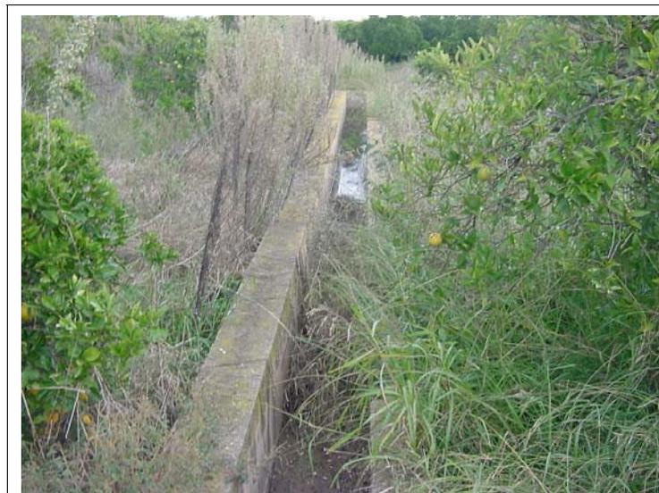
**FOTO N°570: Acequia de 50x50 cm y muros de 20 y 30 cm de ancho.**
