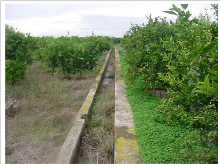
**FOTO N°321: Acequia de 60x40 con muros laterales de 20 y 40 cm.**
