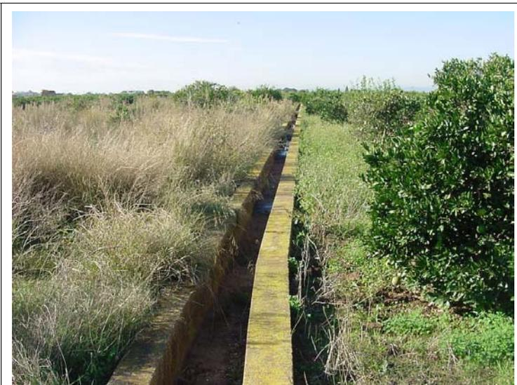
**FOTO N°347: Acequia de 50x60 cm con muros de 30 cm de ancho.**
