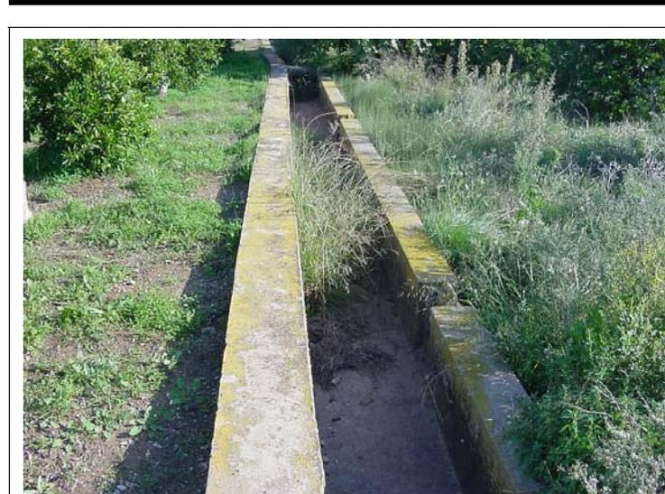
**FOTO N°484: Acequia de 80x60 cm y muros de 30 y 40 cm de ancho**
