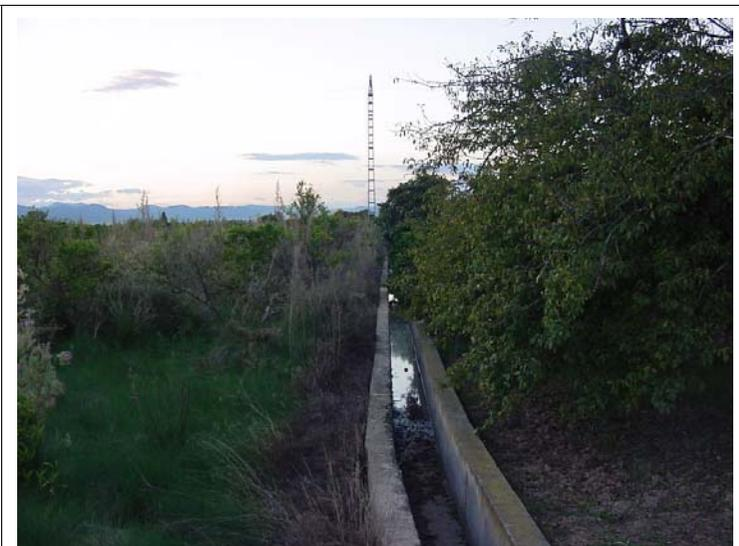
**FOTO N°467:**Acequia de 50x50 cm y muros de 30 y 20 cm de ancho. Al fondo poste de media tensión.
