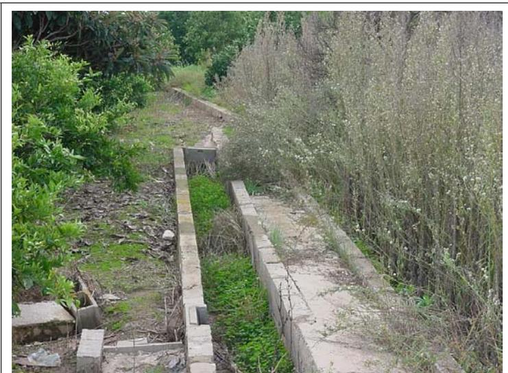
FOTO N°299: Acequia de 50x50 y muretes con bloques de hormigón de 15 cm y 60 cm de ancho.
