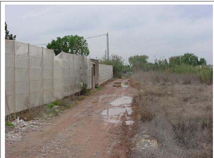
**FOTO N°151: Cerramiento de 3 m de altura formado por bloques de hormigón y tela metálica.**
