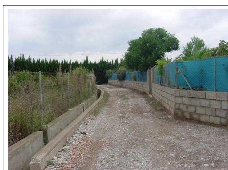
**FOTO N°56:** Camino en tierra estabilizado con gravilla de 3 m de ancho y acequia de 40x80 cm.
