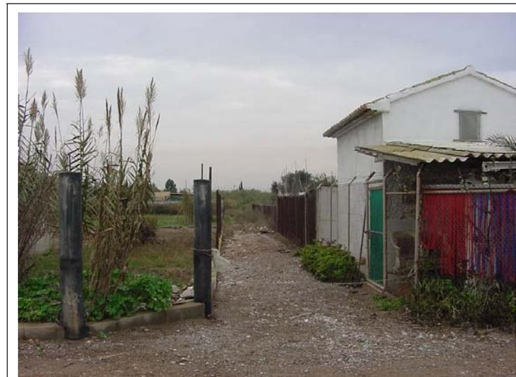
**FOTO N°168: Camino en tierra de 4.5 m de ancho. Cerramiento formado por murete de hormigón de 0.15 m y valla metálica de 2.20 m de altura.**
