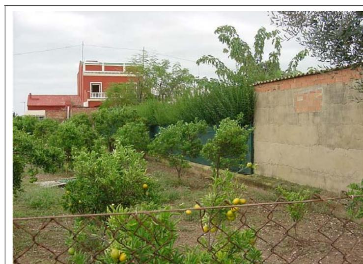
**FOTO N°28: Límite entre parcelas con murete de 20 cm de altura y valla metálica de 2 m de altura.**
