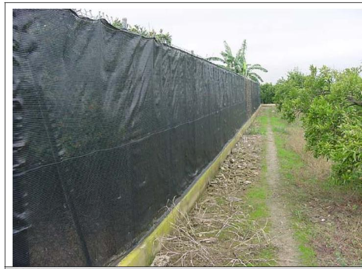
**FOTO N°116: Cerramiento de 2.50 m de altura formado por muro de hormigón de 30 cm y valla metálica.**
