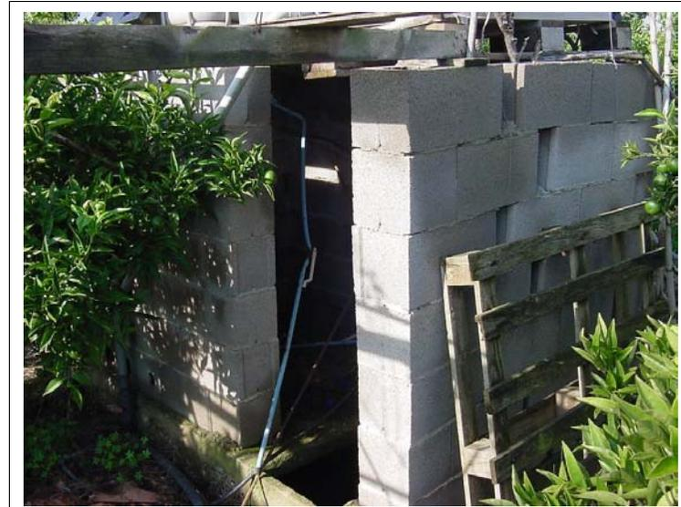
**FOTO N°218: Obra en bloques de hormigón de 2 m de altura para tanques de fertilización bajo alberca.**
