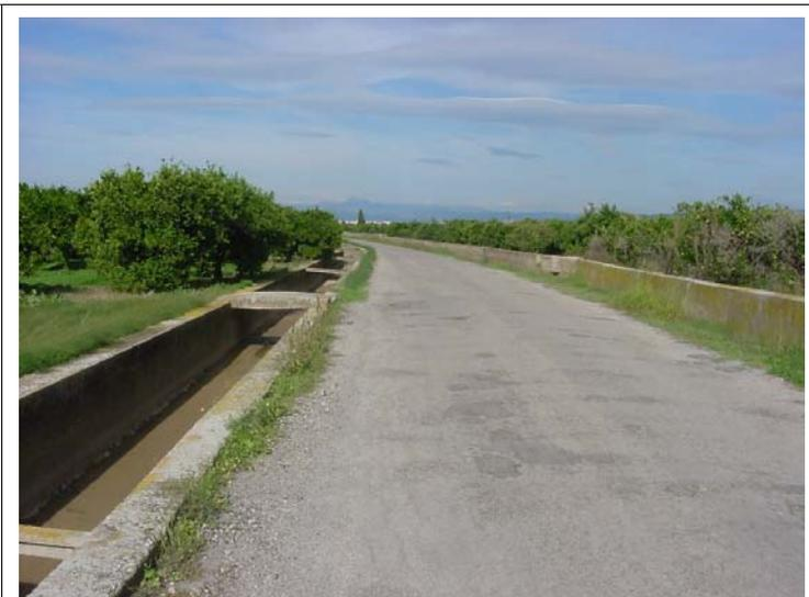
**FOTO N°499: Carretera de 6 m de ancho bordeada por dos acequias de dimensiones interiores 1.5x0.9 m y 0.6x1.2 m.**
