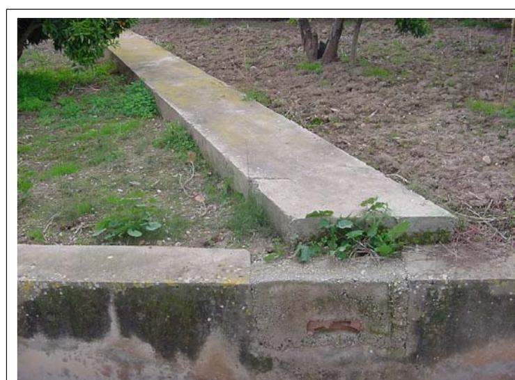
**FOTO N°640: Acequia rellena con hormigón de dimensiones exteriores 80x40 cm en el límite de la urbanización.**
