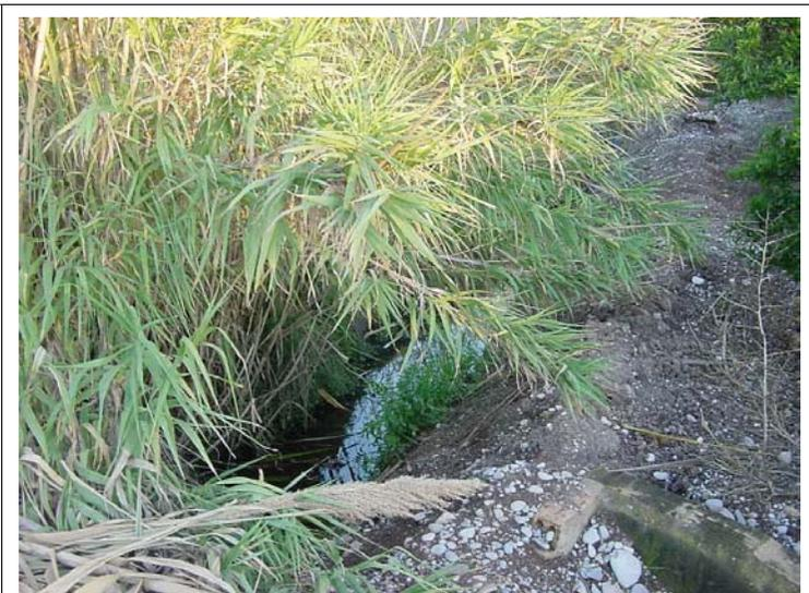
**FOTO N°459: Acequia excavada en tierra de 3 m de ancho y 1.5 de calado.**
