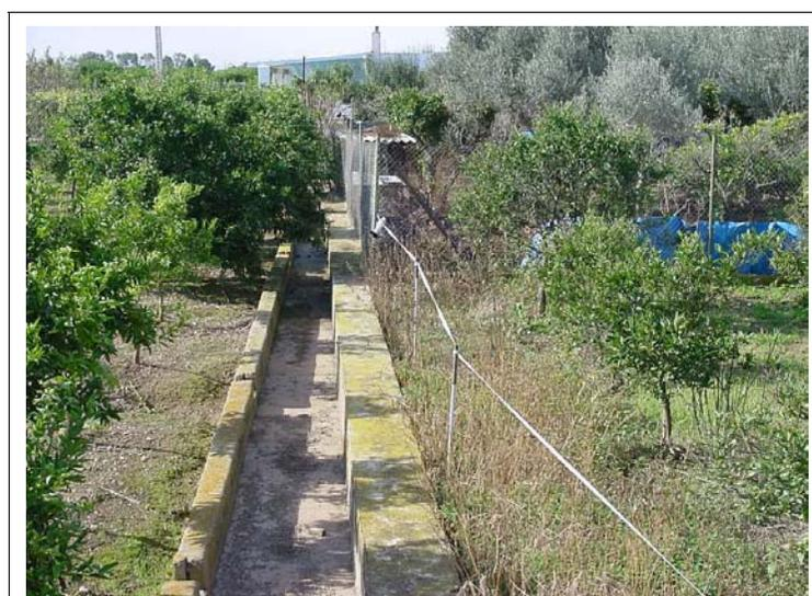
**FOTO N°496: Acequia de dimensiones interiores 70x25 cm. Cerramiento formado por valla metálica de 1.50 m de altura.**
