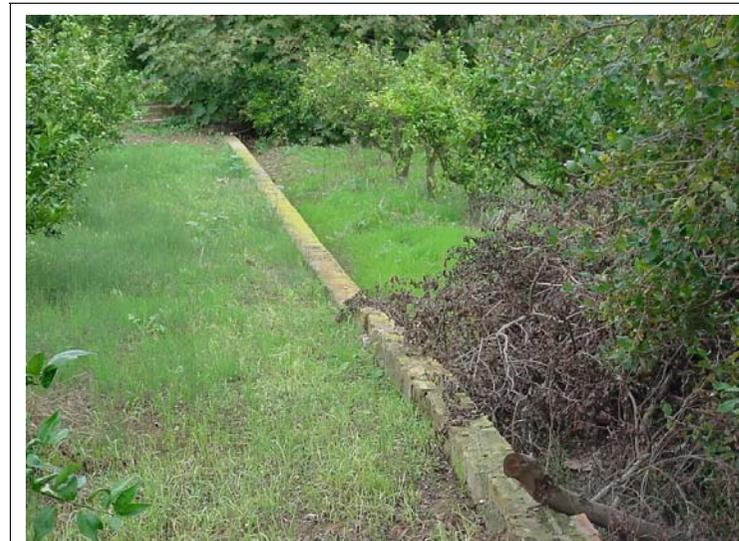
**FOTO N°12:** Murete de hormigón de 20 cm de altura para separación de parcelas.
