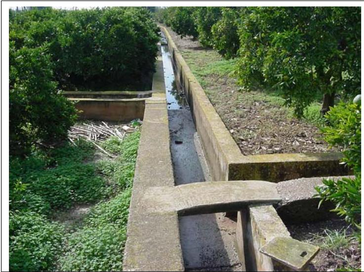
**FOTO N°269:** Acequias de dimensiones interiores (de izquierda a derecha), 60x60, 60x60 y 50x60 cm.
