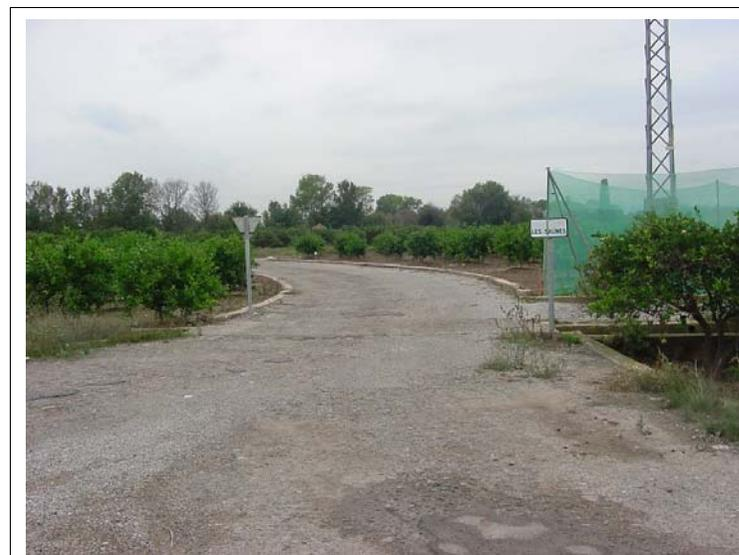
**FOTO N°18: Camino pavimentado de 5 m de ancho bordeado por muretes de hormigón de 20 cm de altura.**
