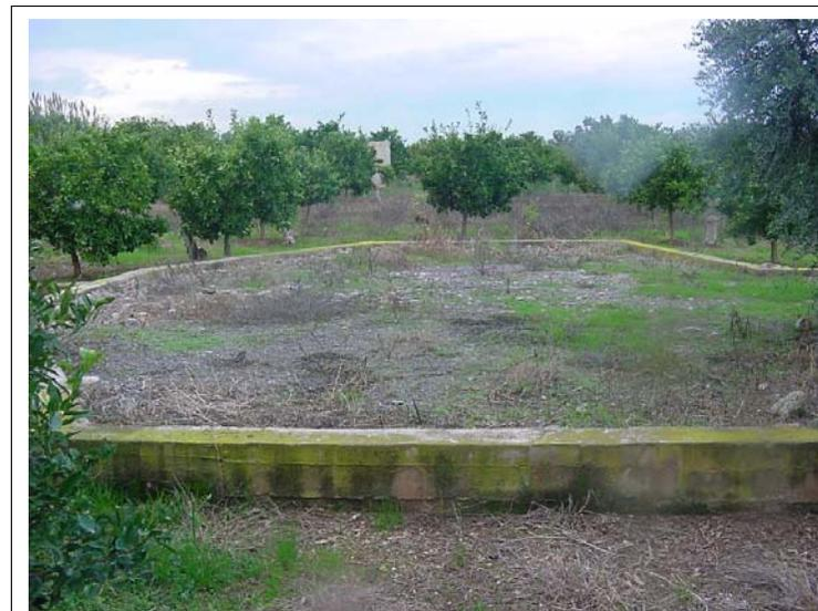
**FOTO N°314:**Explanada delimitada por muretes de hormigón de 25x35
