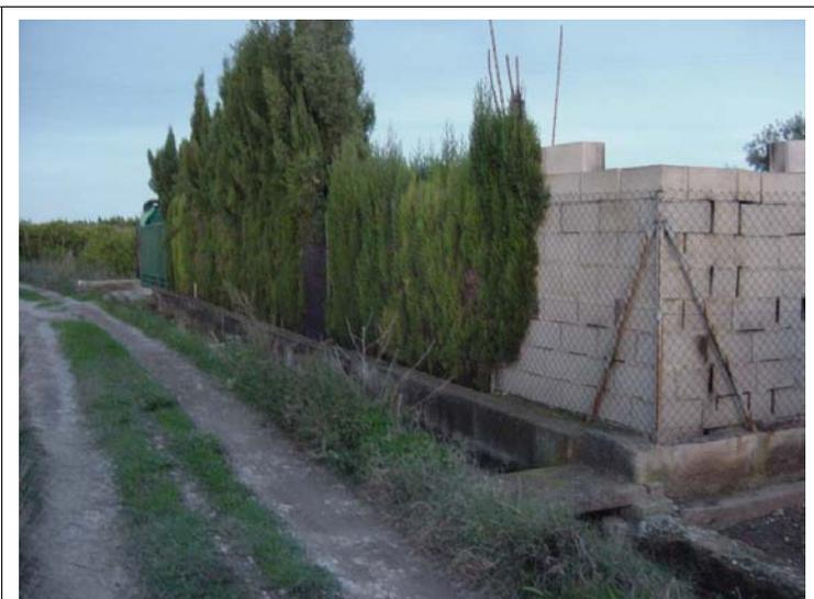
**FOTO N°591:** Cerramiento de valla metálica de 1.5 m sobre murete de la acequia.
