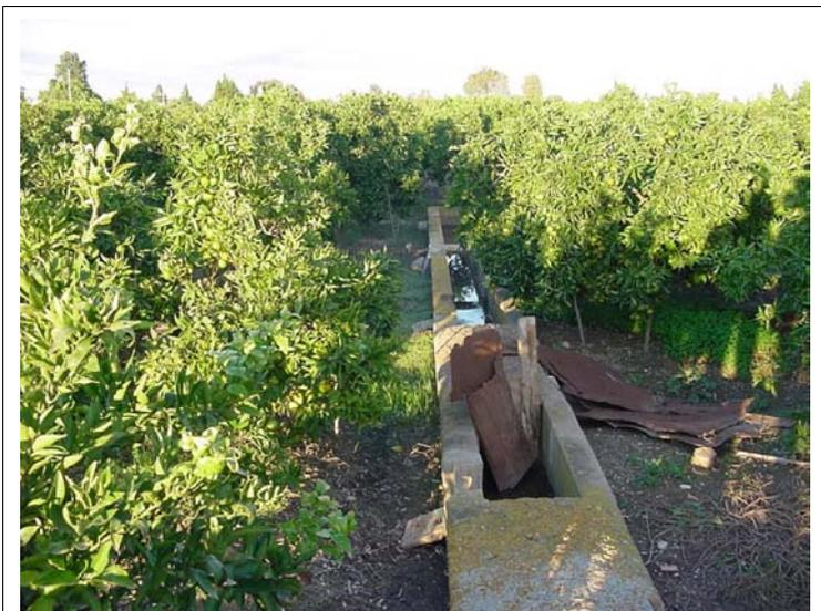
**FOTO N°457: Acequia de 50x50 con muros de 20 cm de ancho.**
