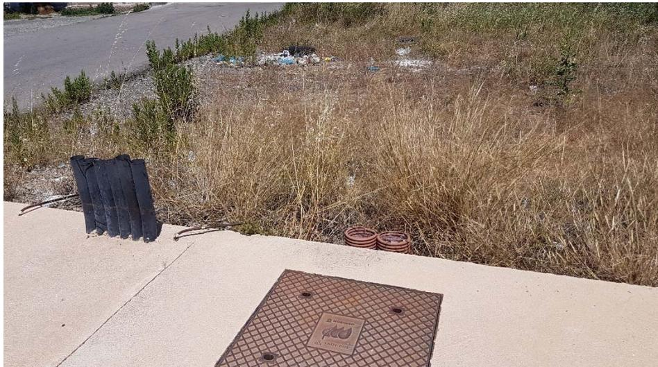
Fotografía 14.- Conductos de PVC de Telefónica.
