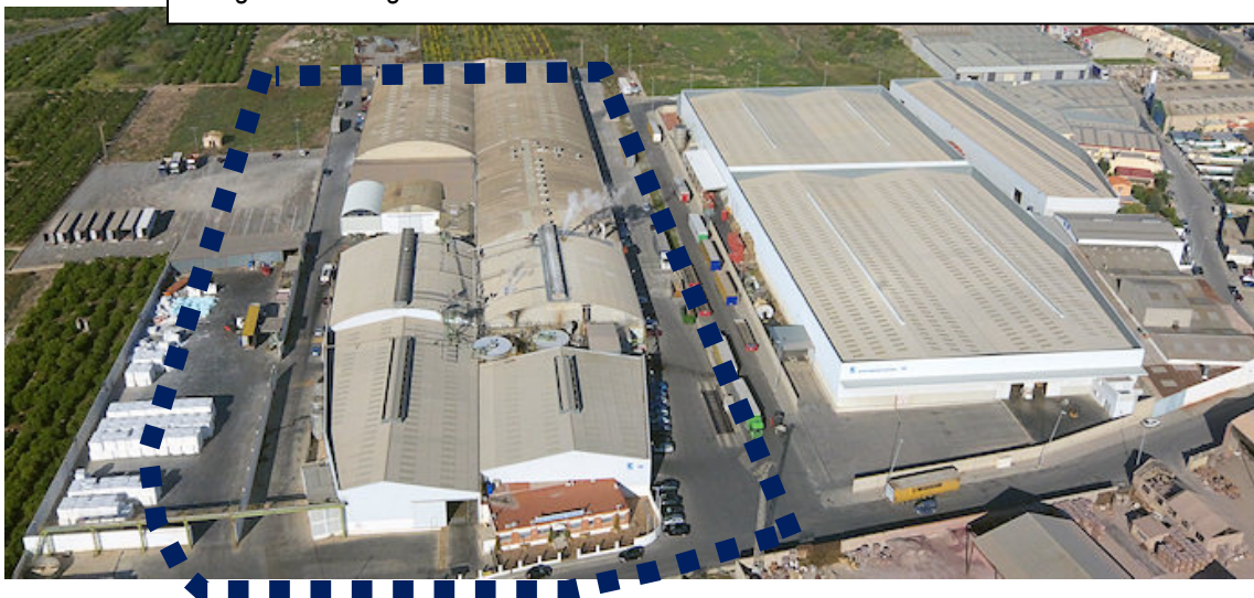
Imagen nº6. Polígono industrial del Camí Fondo – Camí Xamussa. Borriana. Estado actual.
