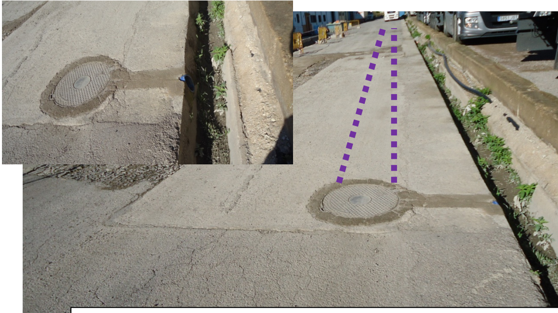
Imagen nº11. Colector de saneamiento y cuneta. Vial privado noreste.
