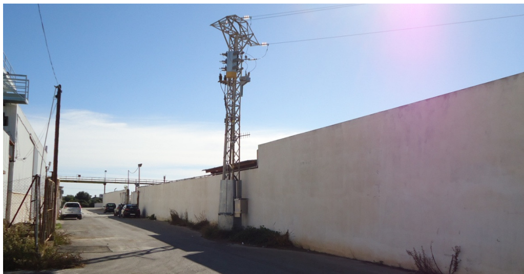
Imagen nº7. Línea aérea AT 20 kV. Torre entronque A/S. Vial privado..
