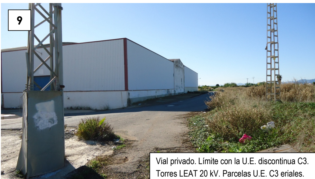
Vial privado. Esquina noreste del ámbito. Línea eléctrica AT 20 kV. Suministro U.E. C2/C3
