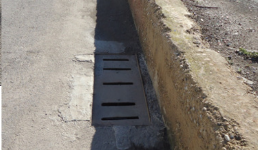
Imagen nº12. Colector de saneamiento e imbornal. Vial privado suroeste.
