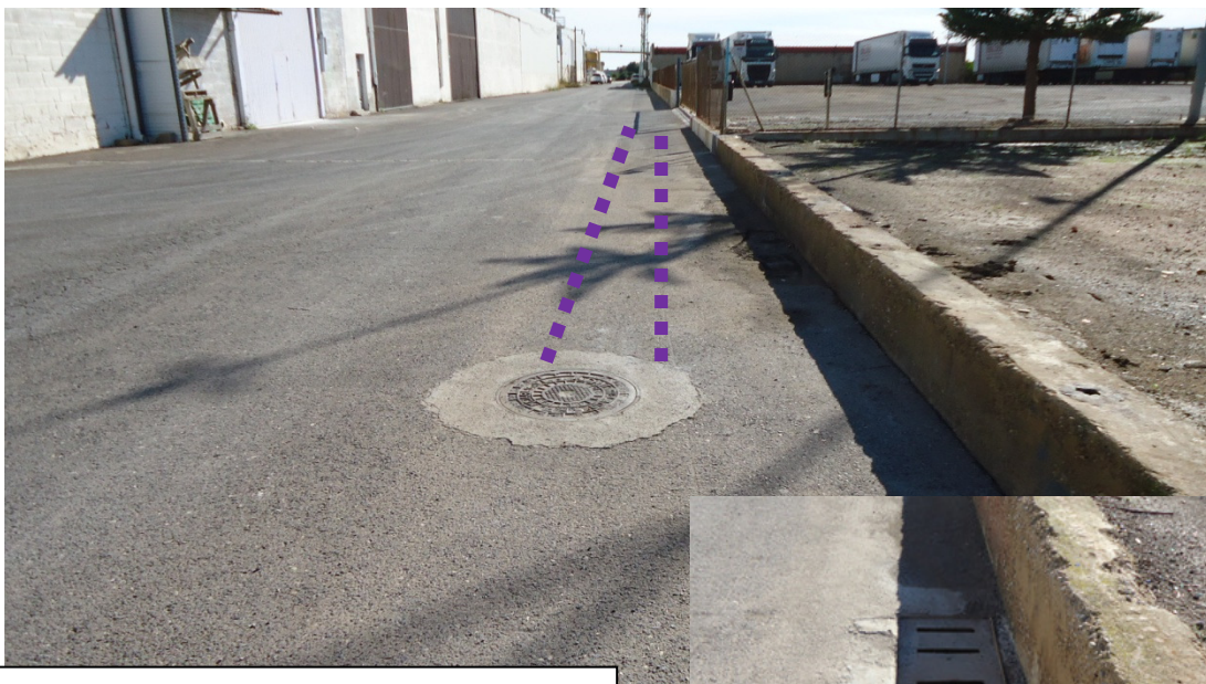
Imagen nº12. Colector de saneamiento e imbornal. Vial privado suroeste.
