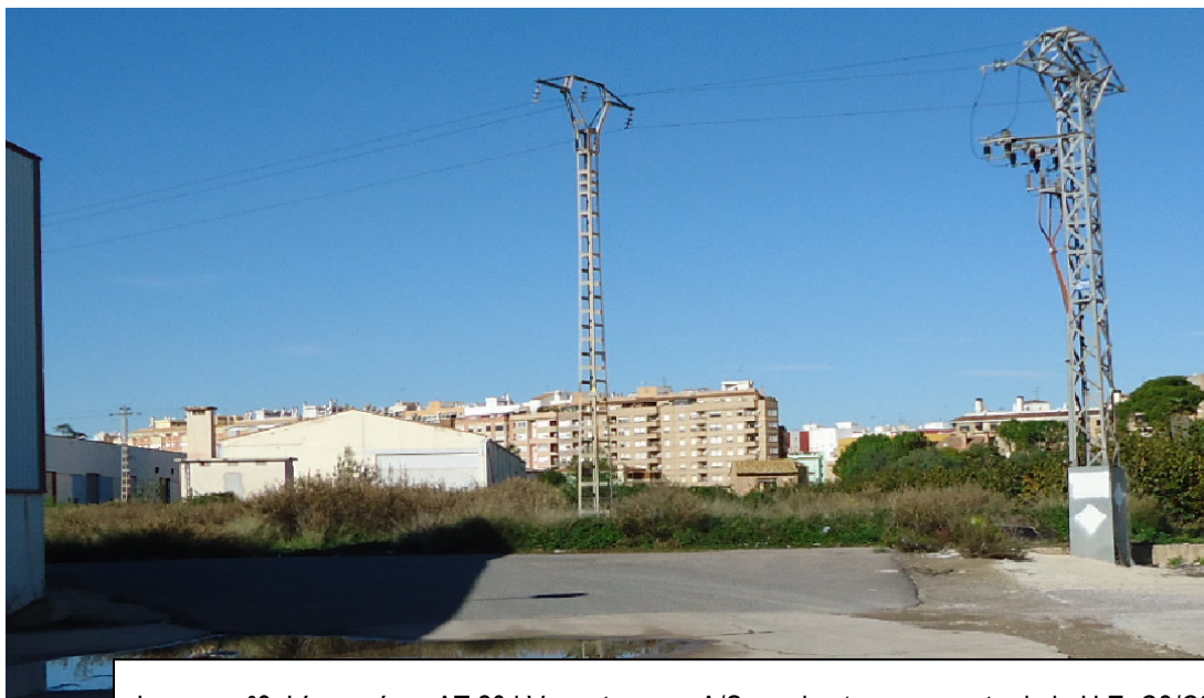
Imagen nº9. Línea aérea AT 20 kV y entronque A/S en el extremo noreste de la U.E. C3/C3.
