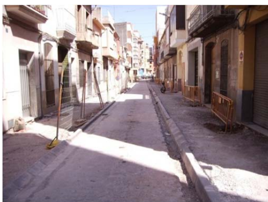
Obra de ampliación y mejora de acera en calle de Burriana
