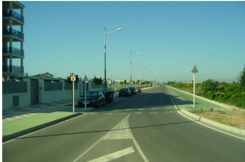
Perspectiva general de la Avda. Cañada Blanch. A la derecha de la imagen se observa el trazado del carril bici.
