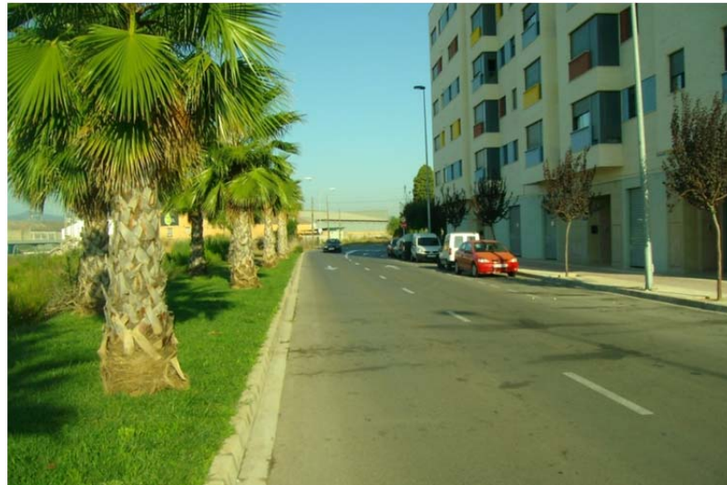
Perspectiva del trazado del vial existente desde la rotonda de la Avinguda del Transport en su encuentro con la Avinguda de Nules.
