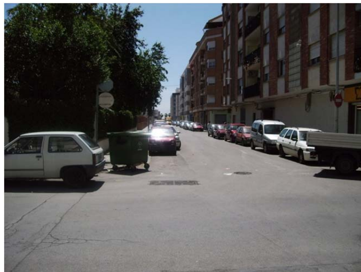
Intersección sin la debida señalización horizontal de marcaje de STOP. Se observa a la izquierda de la imagen la señalización vertical que indica STOP.
