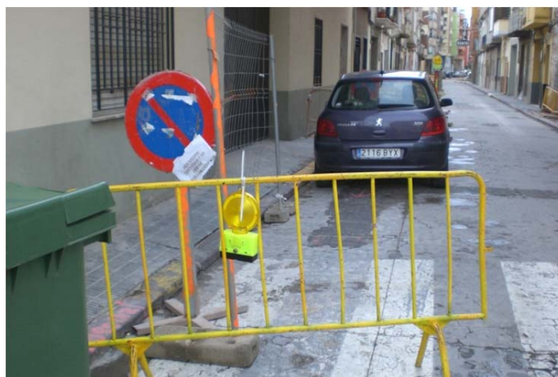
Calle con aceras de anchura insuficiente
