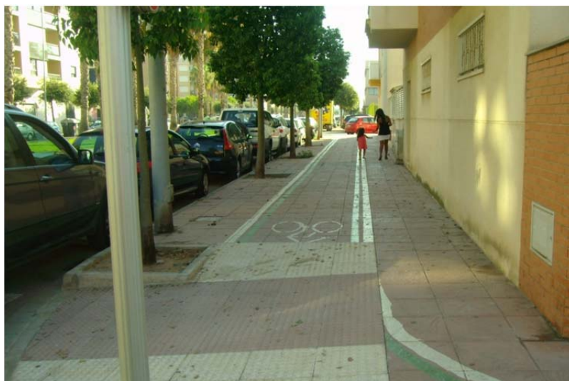
Carril bici pintado sobre el pavimento de acera en Avda. Cardenal Vicente Enrique Tarancón. Se observa el escaso espacio que queda para los peatones.
