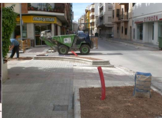
Mejora de acera y rampa peatonal Avda. Corts Valencianes
