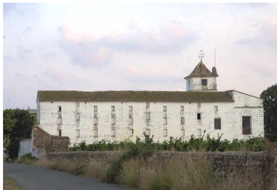
Figura 4: Torre del Carabona.
