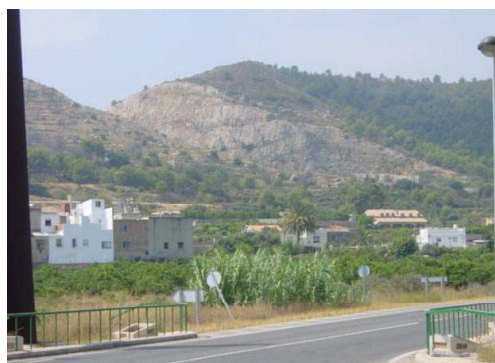
Taludes de la A7 a su paso por Oliva (Valencia)
