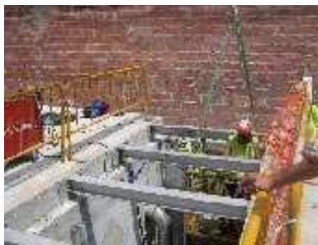
Obras de saneamiento en Benicàssim-Castellón (Castellón)
