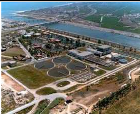
Estación Depuradora de Pinedo 2 (Valencia).
