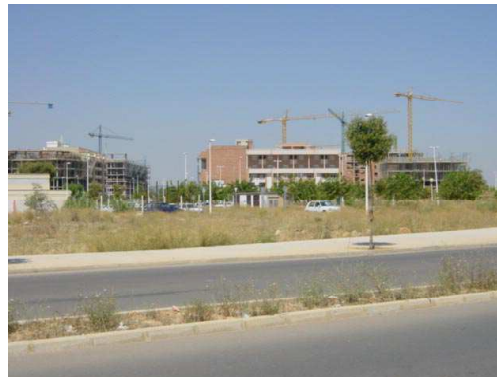
Construcción de viviendas a las afueras del casco urbano de Catarroja (Valencia)
