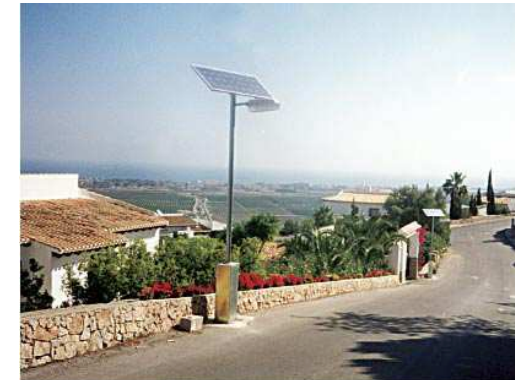
Alumbrado vial con energía solar en urbanización MontePego I, Pego (Alicante)
