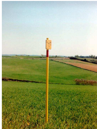
Señalización de conducción de gas .
