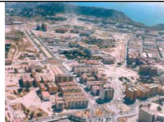
Gran Via de Alicante, Tramo IV (Alicante)
