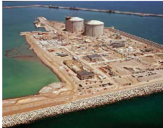
Construcción de Planta Regasificadora de Sagunto (Valencia)
