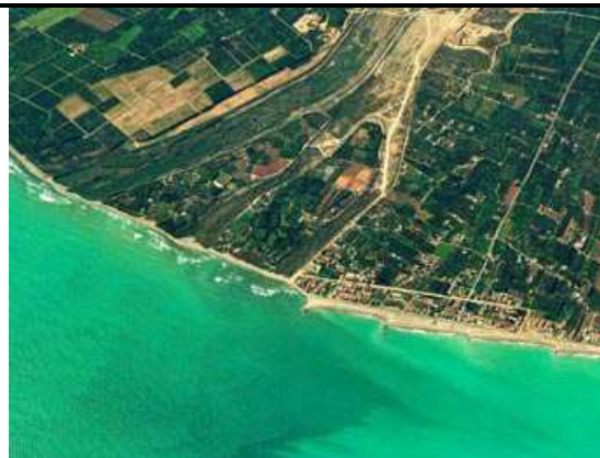
Desembocadura del río Mijares (Castellón)
