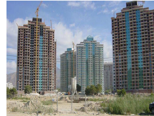
Cuatro hoteles de gran altura en construcción en la cala de Finestrat (Alicante)
