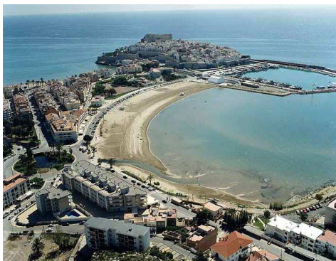
Puerto de Peñíscola (Castellón)
