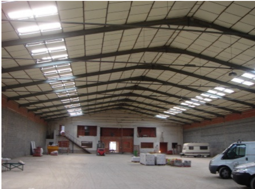
INTERIOR DE UNA DE LAS NAVES
