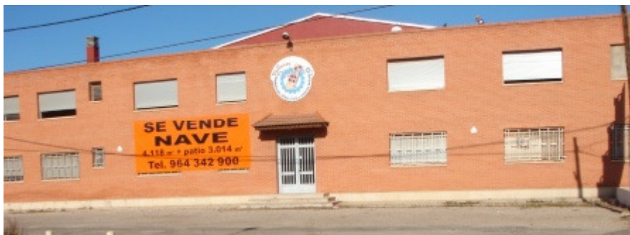
FACHADA DE UNA DE LAS NAVES
